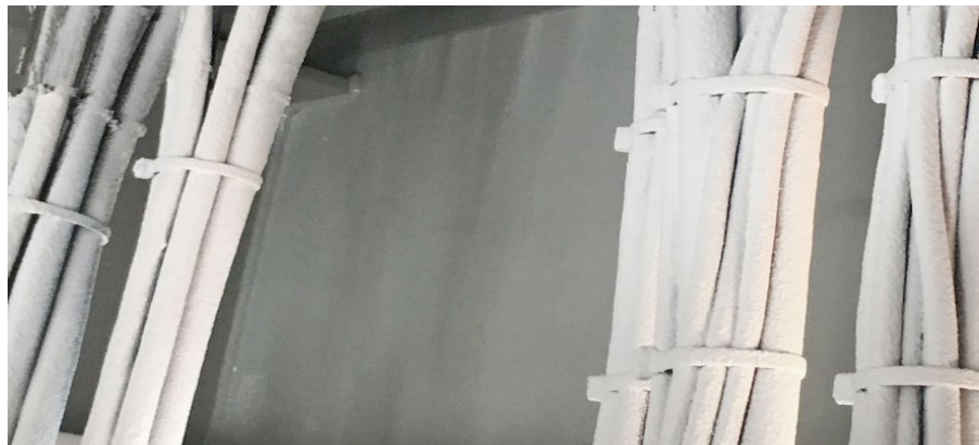
Рисунок 7. Обробка електричних кабелів методом нанесення
