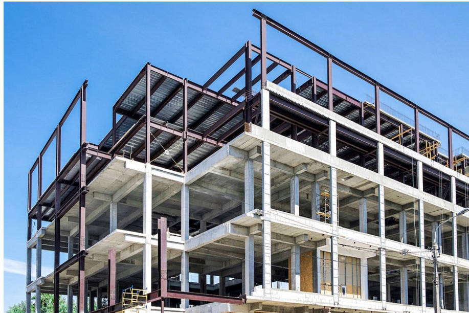
Рисунок 1.3 – Капітальний ремонт будівництва
