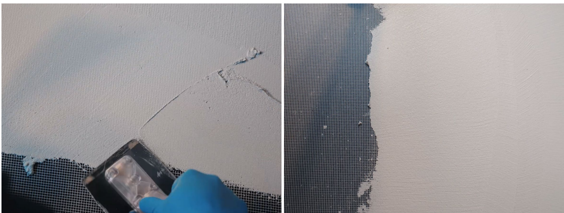
Рисунок 4.3.1 – Посилення залізобетонних конструкцій обклеюванням вуглеволокном
