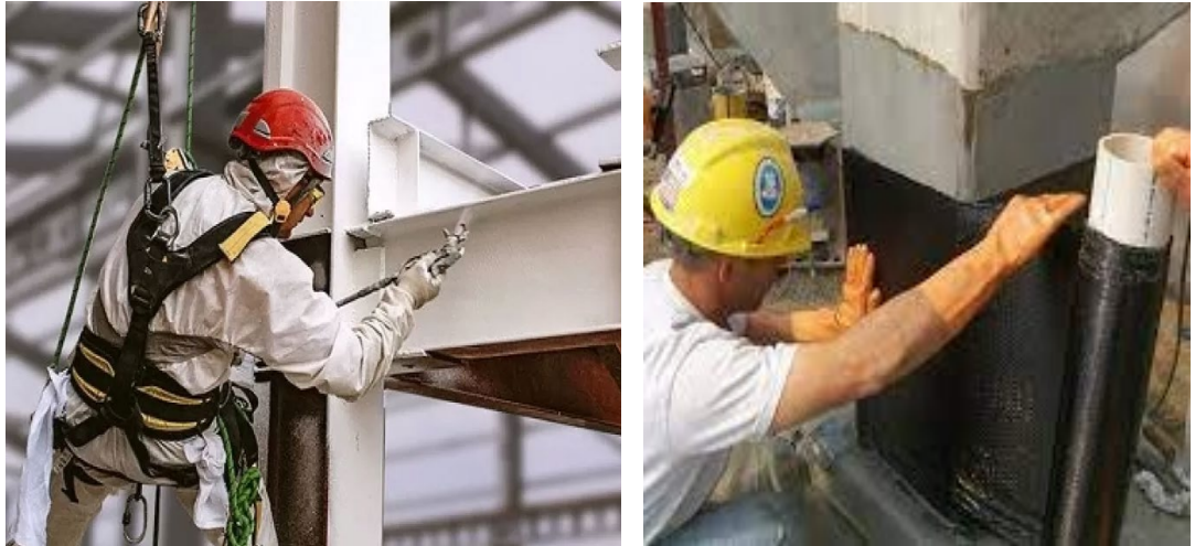
Рисунок 4.5 – 1. Нанесення антикорозійного складу на арматуру;
