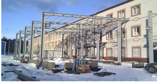
Рисунок 3.1 – Приладка до основної будівлі
