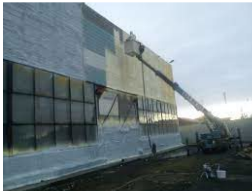
Рисунок 4.6 – Підвищення теплового захисту огорожуючих конструкцій будівлі
