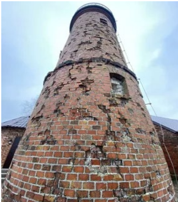
Рисунок 4.2 – Посилення експлуатованої цегляної димової труби, пошкодженої вертикальними тріщинами
