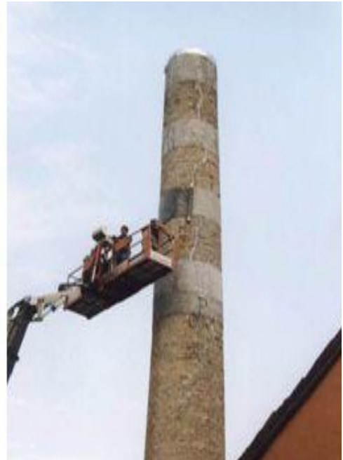
Рисунок 4.2 – Посилення експлуатованої цегляної димової труби, пошкодженої вертикальними тріщинами
