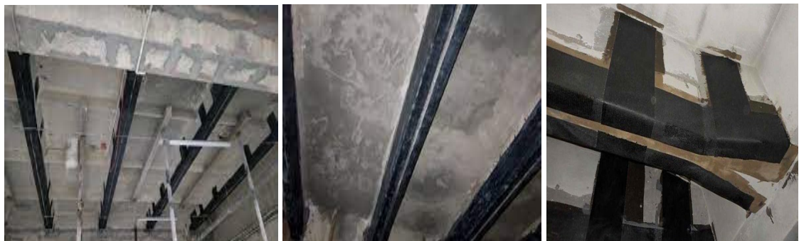
Рисунок 4.4 – Ремонтовані плити вуглеволокном SIGRATEx.
