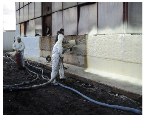
Рисунок 4.6 – Підвищення теплового захисту огорожуючих конструкцій будівлі
