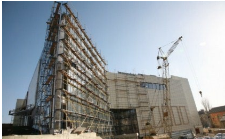
Рисунок 2.1 – Приклад реконструкції складної промислової будівлі
