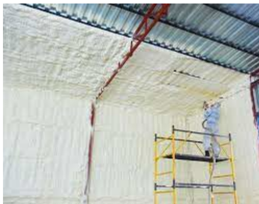
Рисунок 4.6.1 – Підвищення теплового захисту перекриття та кровлі
