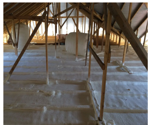
Рисунок 4.6.1 – Підвищення теплового захисту перекриття та кровлі
