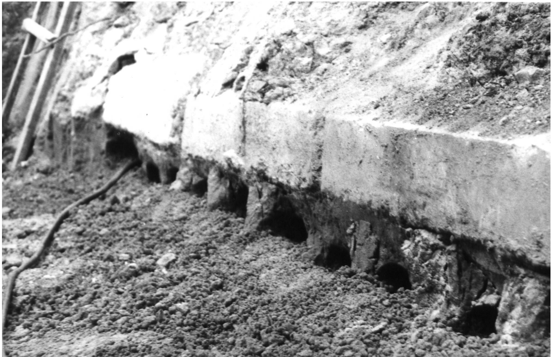
Рисунок 2.5 – Фрагмент ряду пробурених горизонтальних свердловин і подальшого їхнього зволоження
