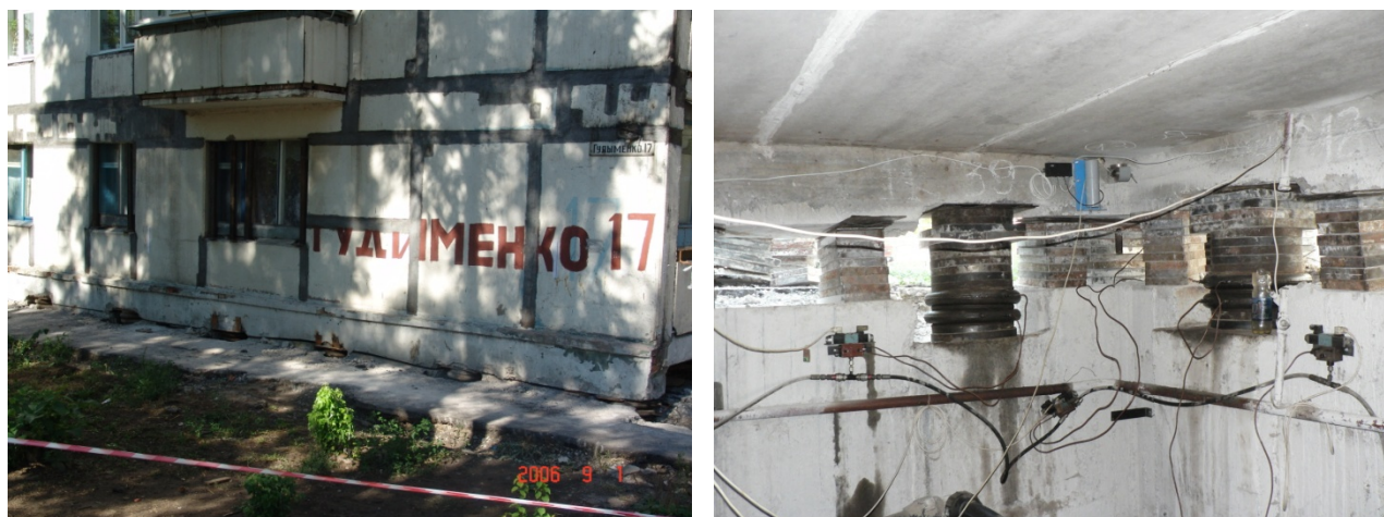
Рисунок 4.12 – Змонтована домкратна система при вирівнюванні блок-секції №1 житлового будинку №17 по вул. Гудименко
