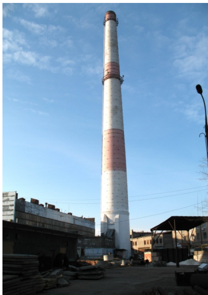
Риунок 4.5 – Загальний вигляд димової труби Н=100м в м. Запоріжжі
