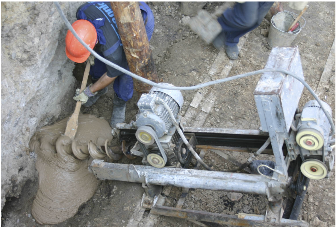
Рисунок 3.2 – Видалення водонасиченого ґрунту з-під фундаменту вибурюванням з лідерних свердловин
