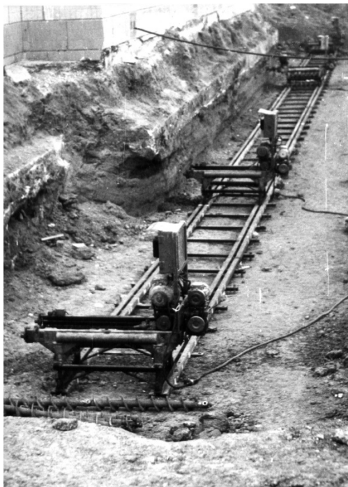
Рисунок 2.4 – Кріплення бурових станків до підставок
