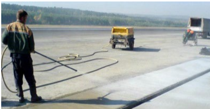
Рисунок 2.5 – Догляд за бетоном у жарку суху погоду
