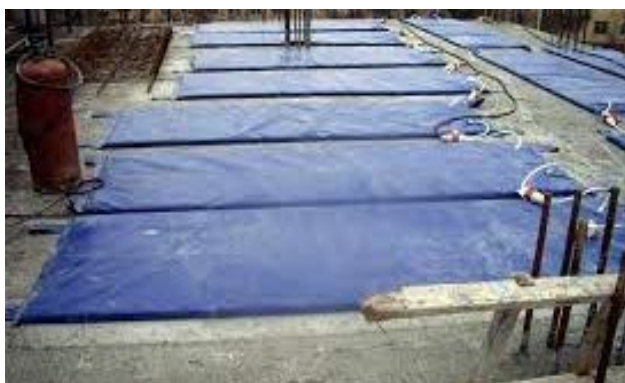
Рисунок 2.5 – Догляд за бетоном взимку
