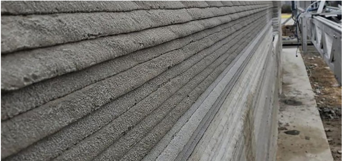
Рисунок 1.5 - Процес відтворення стін будинку
