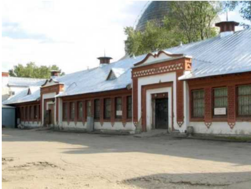
Рисунок 3.1 – Фотографії будівлі павільйону №12
