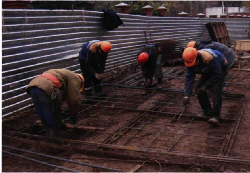
Рисунок 2.4 – В'язка арматурних каркасів стін на шаблоні
