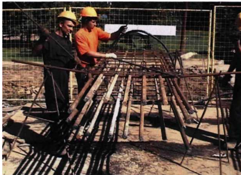
Рисунок 2.5 – В'язка арматурних каркасів пілонів на козлах
