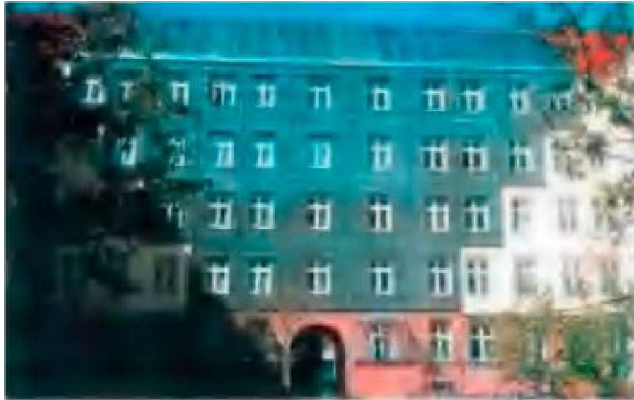
Рисунок 1.3 – Енергоефективний будинок після реконструкції, Данія
