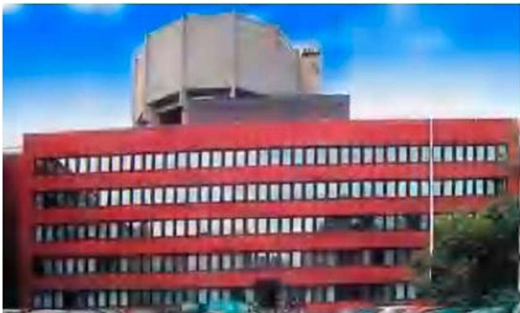
Рисунок 1.2 – Енергоефективна будівля "EKONO-house", Фінляндія
