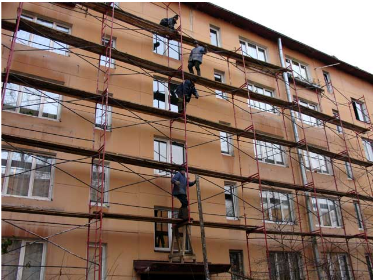
Рисунок 3.1 – Реконструкція будівель груповим методом
