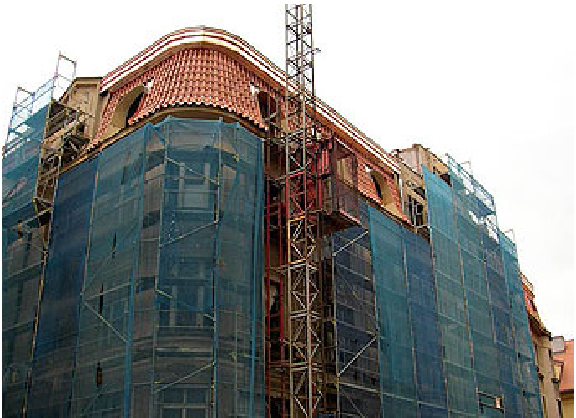
Рисунок 3.2 – Реконструкція будівель груповим методом
