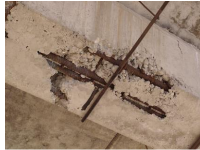
Рисунок 2.2 - Недостатня товщина захисного шару бетону або його відсутності [18].
