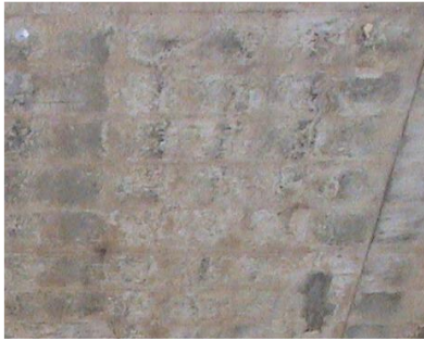
Рисунок 2.2 - Недостатня товщина захисного шару бетону або його відсутності [18].
