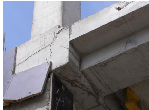
Рисунок 2.3 - Тріщини в конструкціях, викликані порушенням проектних та технологічних вимог [18].
