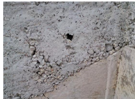
Рисунок 2.1 - Наслідки неякісного ущільнення бетону [18].
