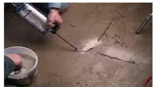
Рисунок 2.4 - Закриття тріщин методом просочення
