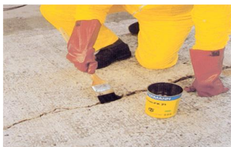
Рисунок 2.4 - Закриття тріщин методом просочення
