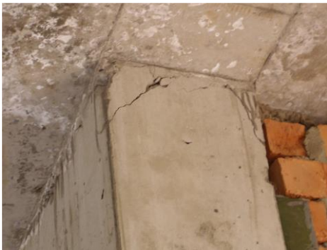
Рисунок 2.3 - Тріщини в конструкціях, викликані порушенням проектних та технологічних вимог [18].
