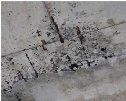
Рисунок 2.1 - Наслідки неякісного ущільнення бетону [18].
