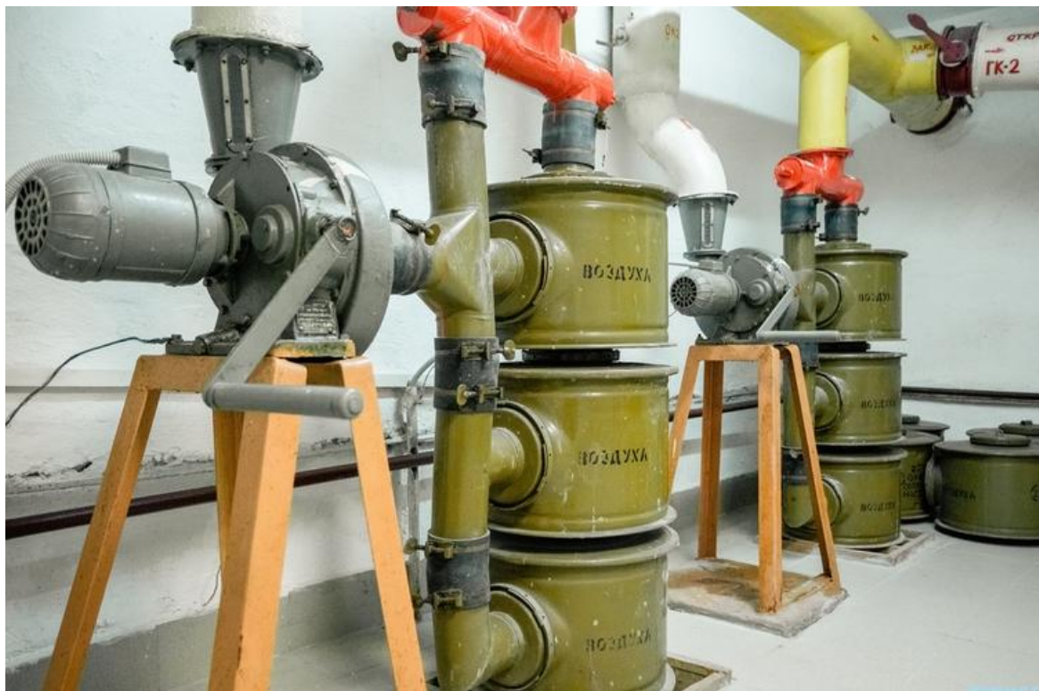
Рисунок 2.19 - Фільтровентиляційний агрегат ФВА-49
