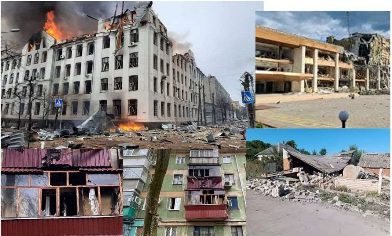
Рисунок 1.1 – Фото зруйнованих або частково розбитих будівель м. Харків і Харківської обл., Україна
