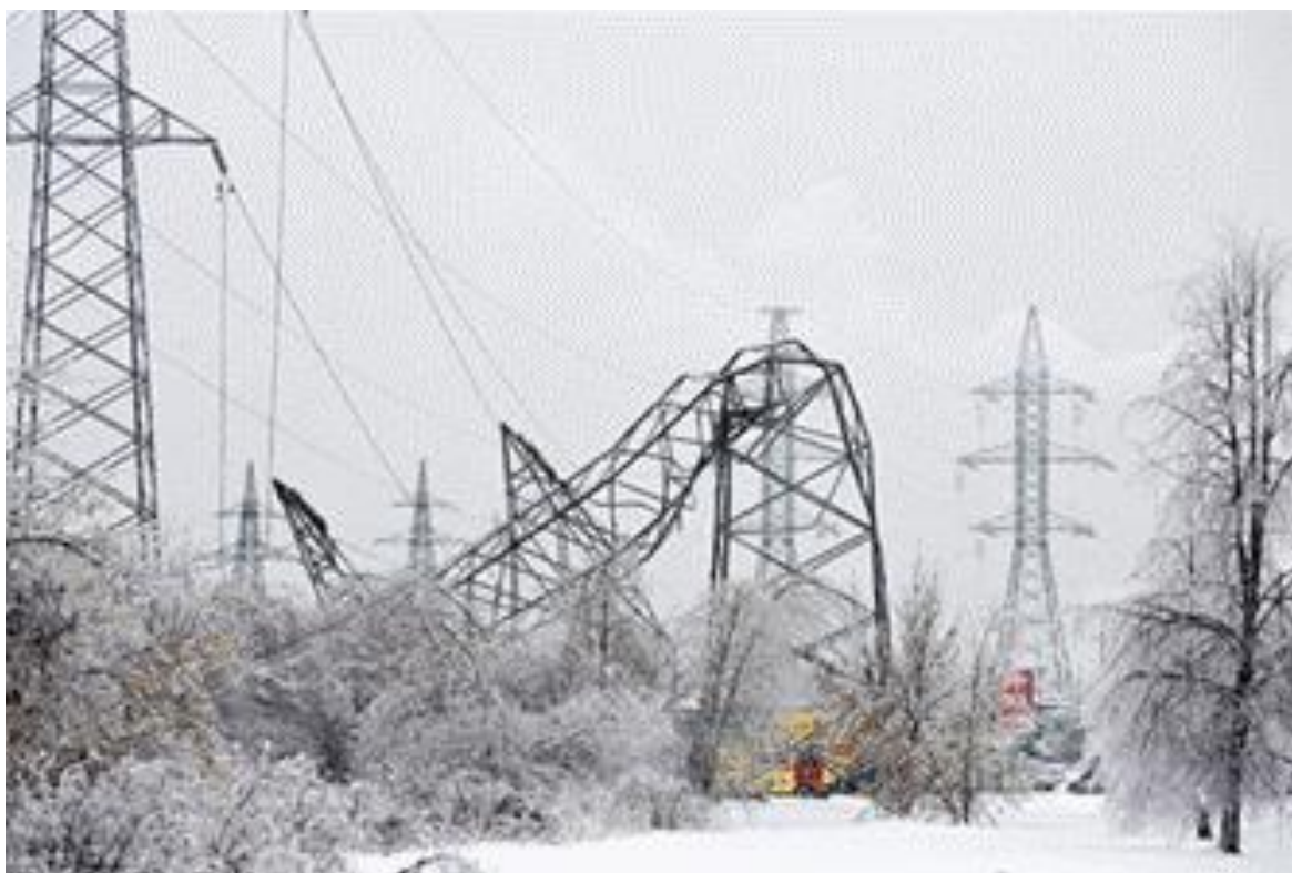
Рисунок 1.3 – Руйнування опори ЛЕП
