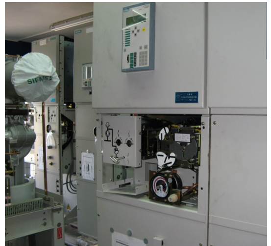
Рисунок 1.20 – Комплектний розподільний пристрій з елегазовою ізоляцією
