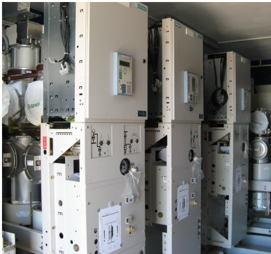
Рисунок 1.20 – Комплектний розподільний пристрій з елегазовою ізоляцією
