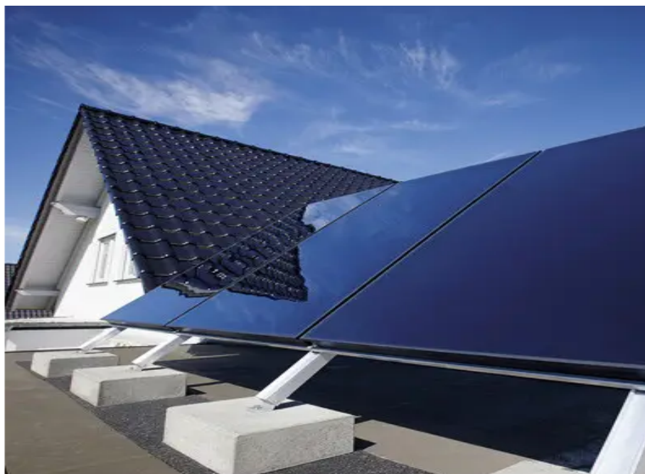
Рисунок 2.14 – Геліосистема підігрівання води
