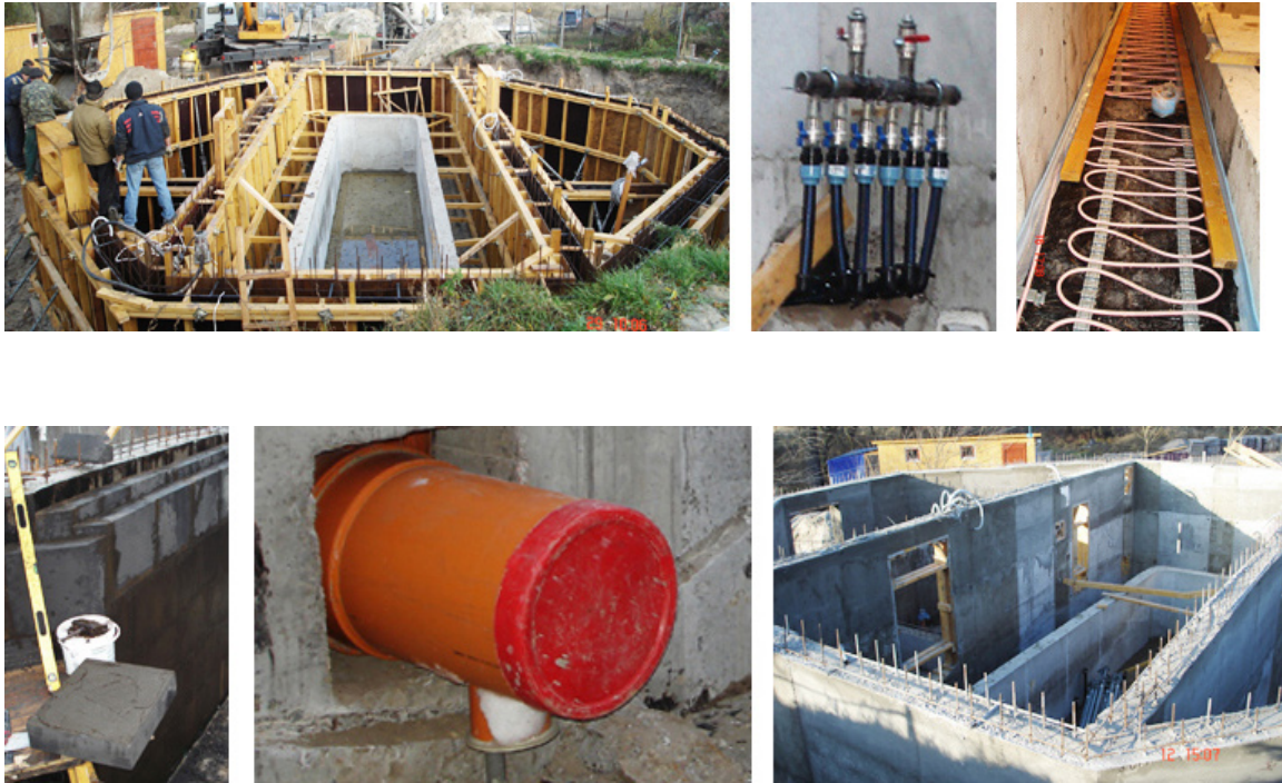
Рисунок 3.4 – Укладання ґрунтового теплообмінника вентиляційної системи
