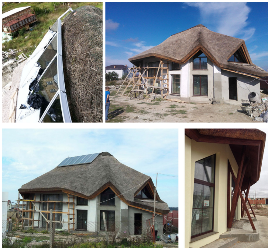
Рисунок 3.20 – Монтаж сонячних колекторів на даху будівлі
