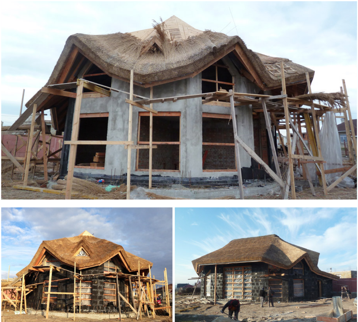
Рисунок 3.18 – Будівельні роботи при влаштуванні «пасивного» екобудинка
