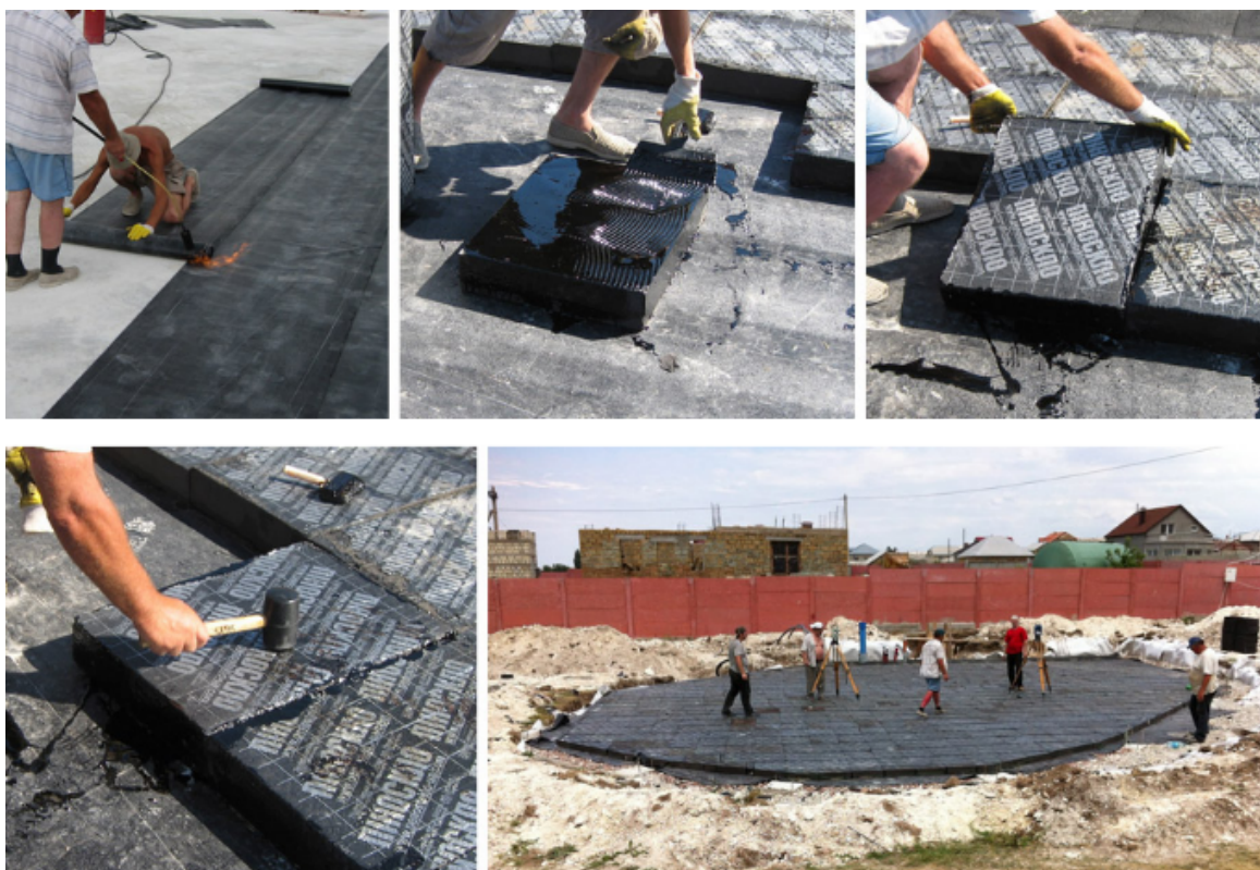
Рисунок 3.17 – Будівельні роботи при влаштуванні «пасивного» екобудинка
