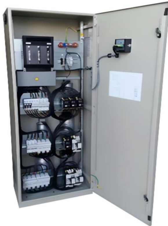
Рисунок 2.10 – Установка компенсації реактивної потужності
