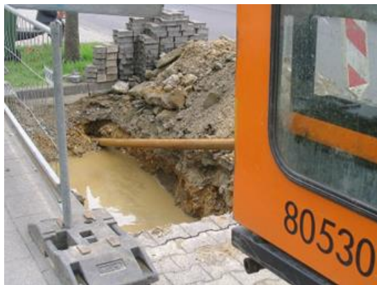
Рисунок 3.3 - Горизонтальне спрямоване буріння
