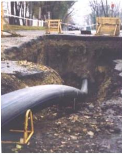
Рисунок 3.2 - Протягання поліетиленової труби усередині сталевій
