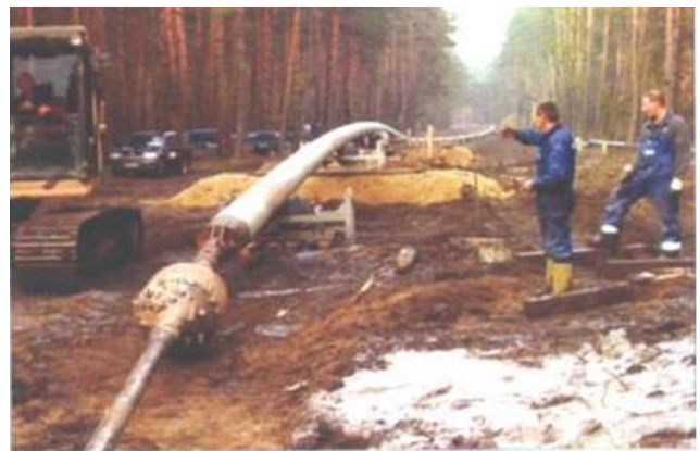
Рисунок 3.3 - Горизонтальне спрямоване буріння
