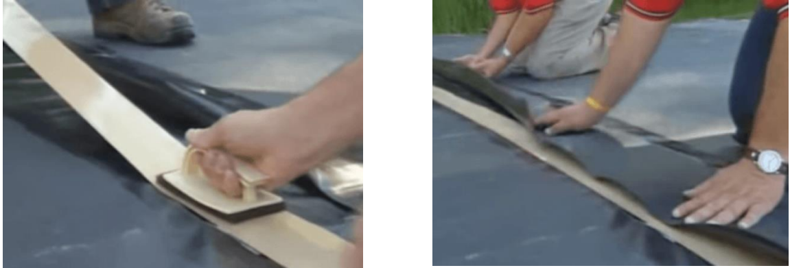
Рисунок 3.1 – Монтаж мембранного покриття (баласна система)
