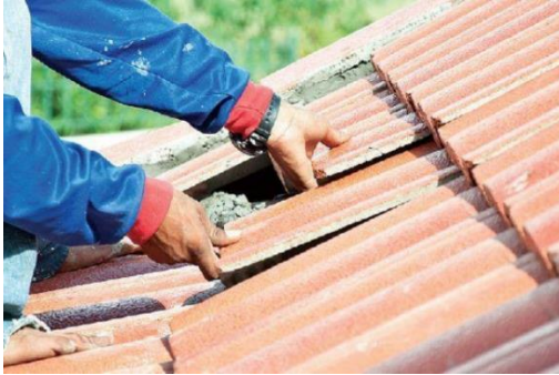
Рисунок 2.7- Ремонт черепичної покрівлі
