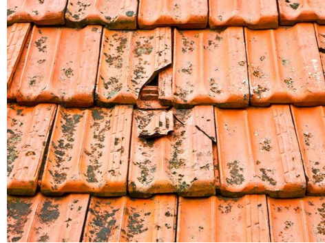
Рисунок 2.7- Ремонт черепичної покрівлі
