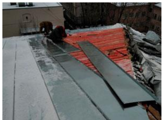
Рисунок 2.2 – Ремонт сталеві покрівлі
