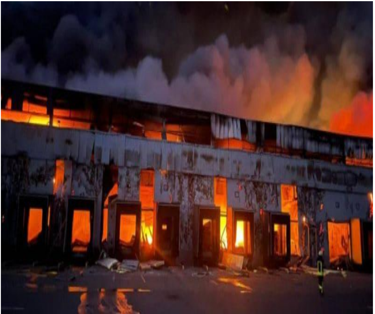
Рисунок 3.12 - Склад с. Квітневе, Броварський район, пожежа внаслідок вибуху. (сендвіч-панелі з пінополіуретану)
