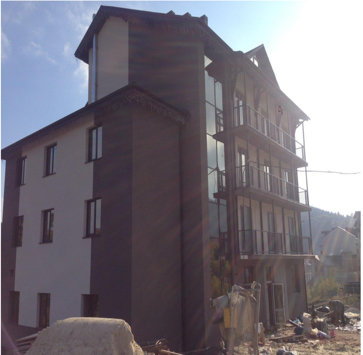
Рисунок 1.24 - Фасад будівлі з тонкошаровою системою зовнішнього утеплення.
