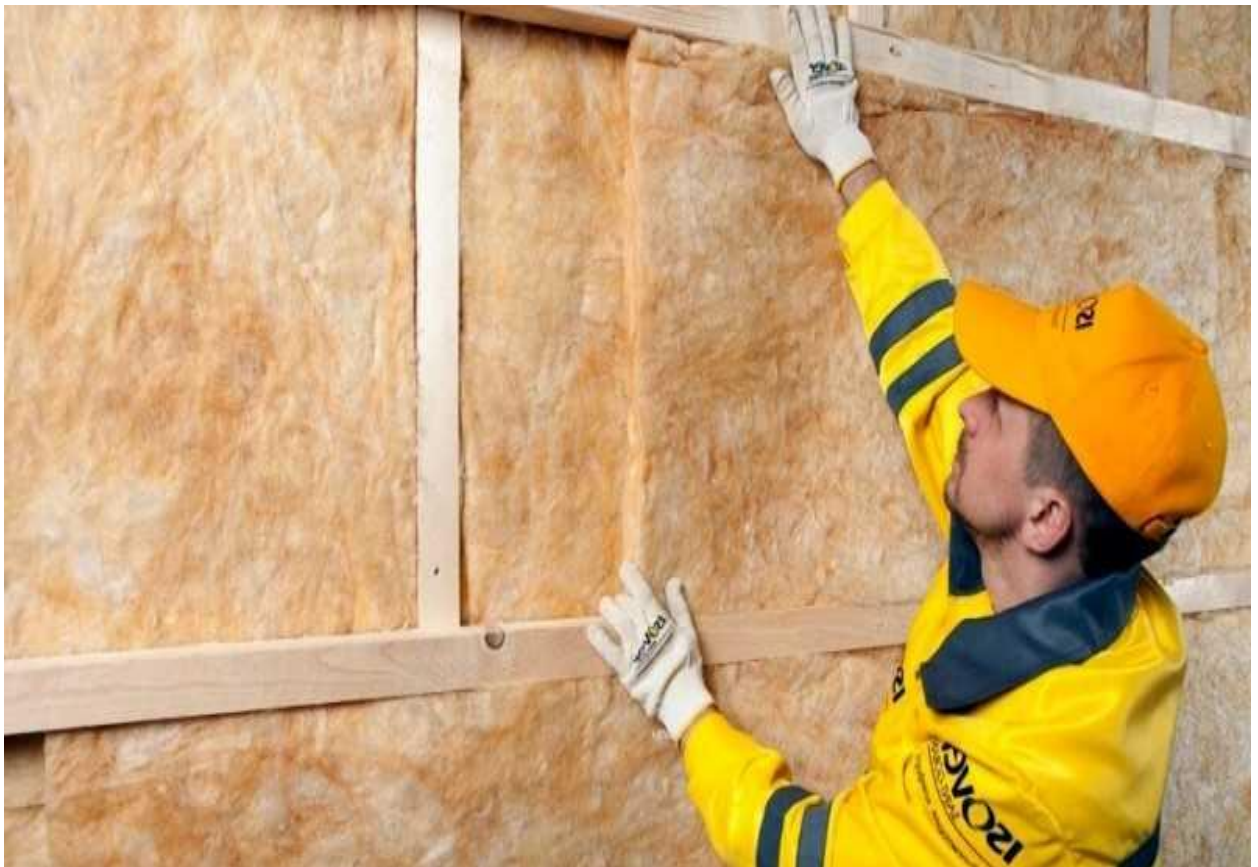
Рисунок 1.26 - Утеплення приміщення із м'якими плитами PAROK
