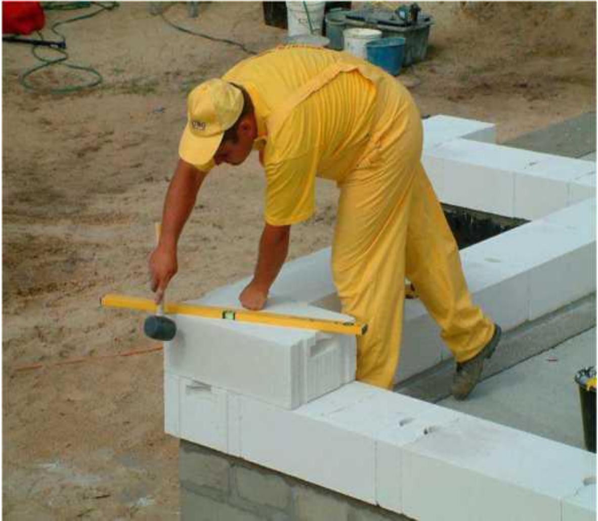
Рисунок 1.10 - Кладка із газобетонних блоків
