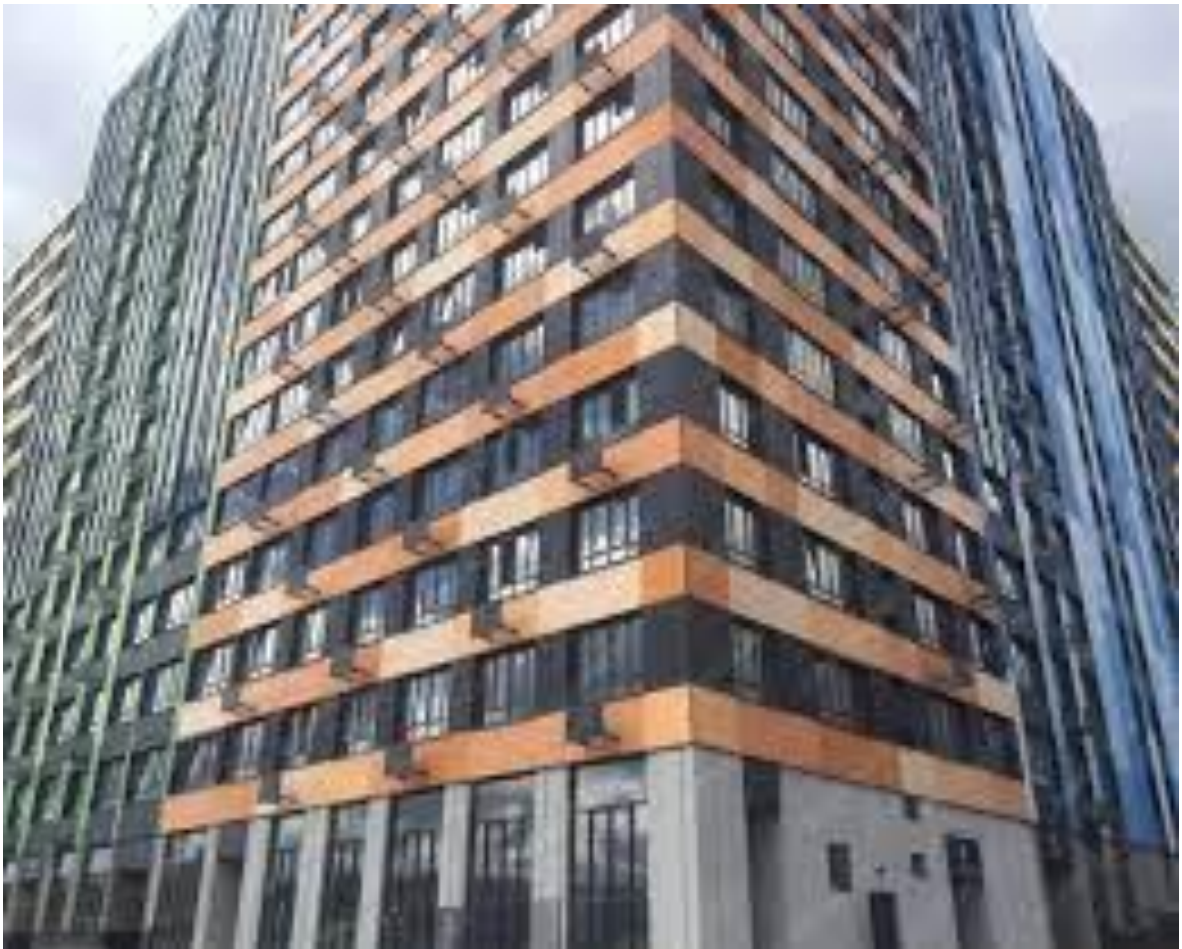
Рисунок 1.25 - Зовнішній вигляд будівлі з вентиляльованим фасадом
