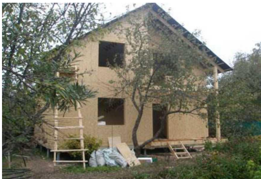
Рисунок 1.16 - Процес складання будинку із СПП-панелей
