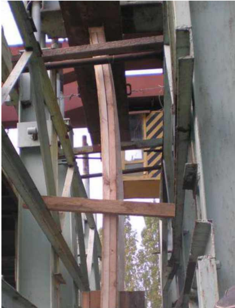
Рисунок 2.13- Втрата стійкості панелі
