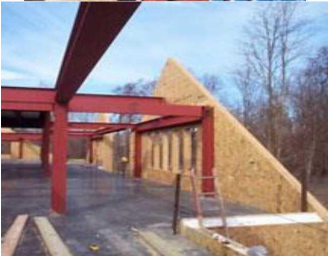
Рисунок 1.9 - Момент збирання будинку на металевому каркасі
