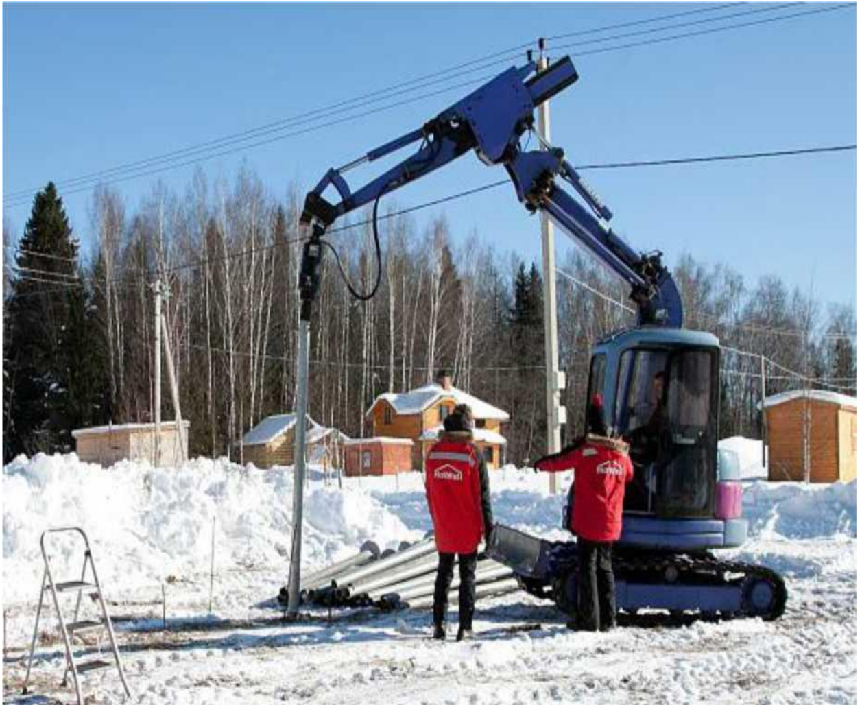
Рисунок 1.18 - Фундамент для канадського будинку на гвинтових палях
