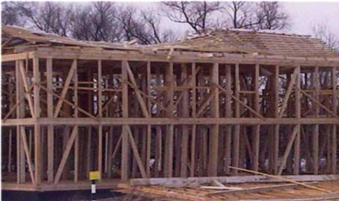
Рисунок 1.19 - Будівництво каркасного будинку
