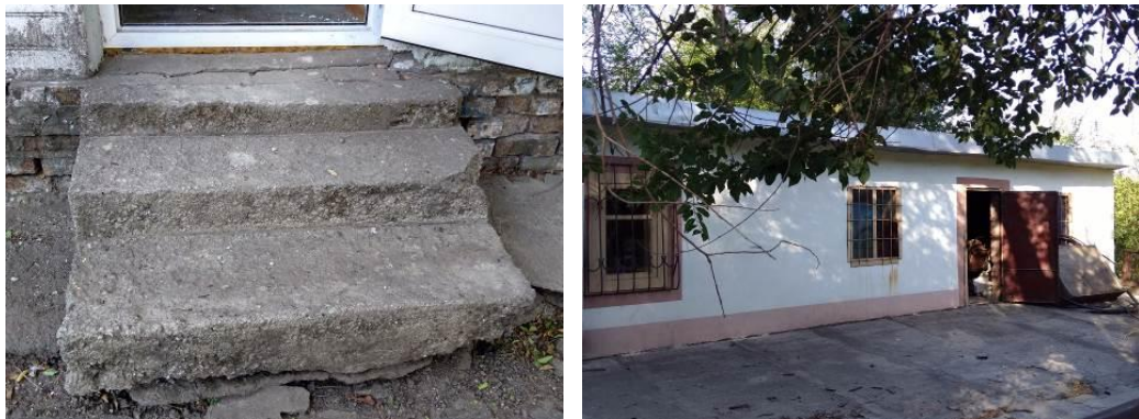
Рисунок 2.3.4 – Приміщення господарського призначення
