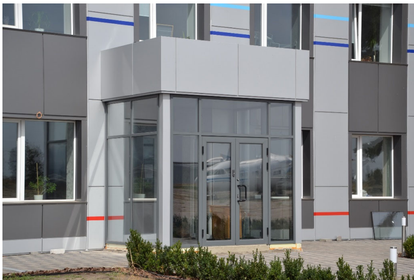
Рисунок 2.6 – Скляні вікна на об'єкті «Капітальний ремонт будівлі АТБ Инв. №0017 по вул. Блакитна, 4 в м. Запоріжжя»
