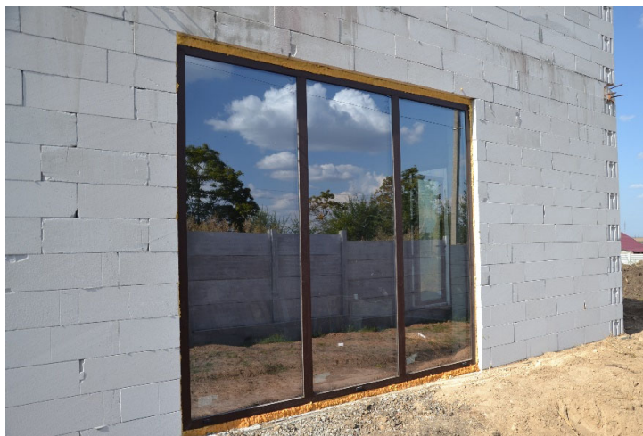
Рисунок 2.5 – Монтаж вікон у приватному будинку, Запорізька область, с. Степове
