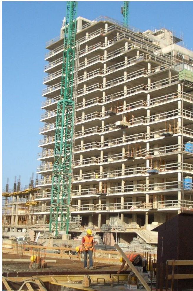
Рисунок 1.1 - Монолітний каркас будівлі
