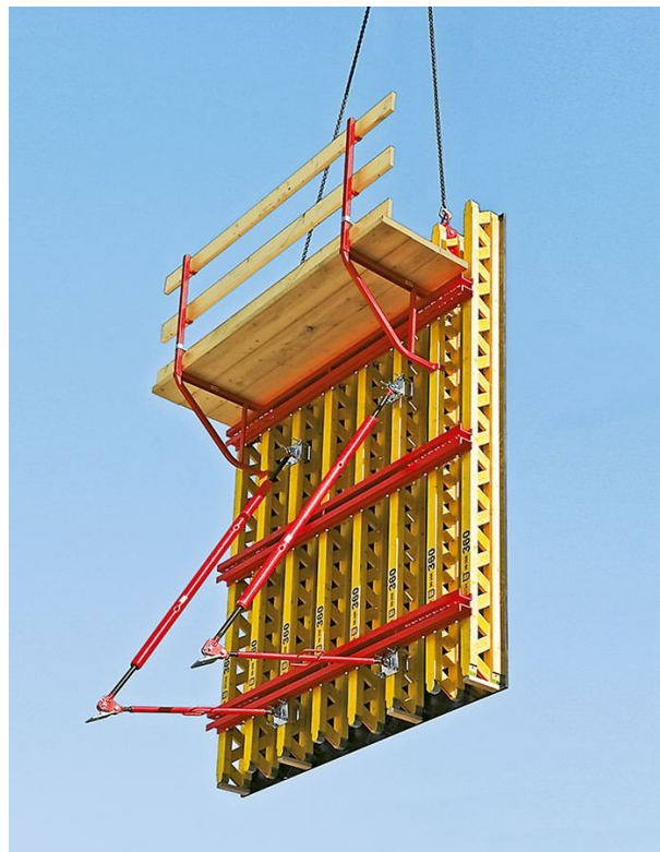
Рисунок 1.15 - Стандартні панелі з елементів системи VARIO GT 24
