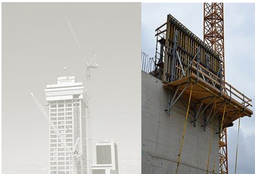
Рисунок 1.7 - Висотна будівля. Нова Зеландія. Такапуна. Робоча платформа ковзаючої опалубки
