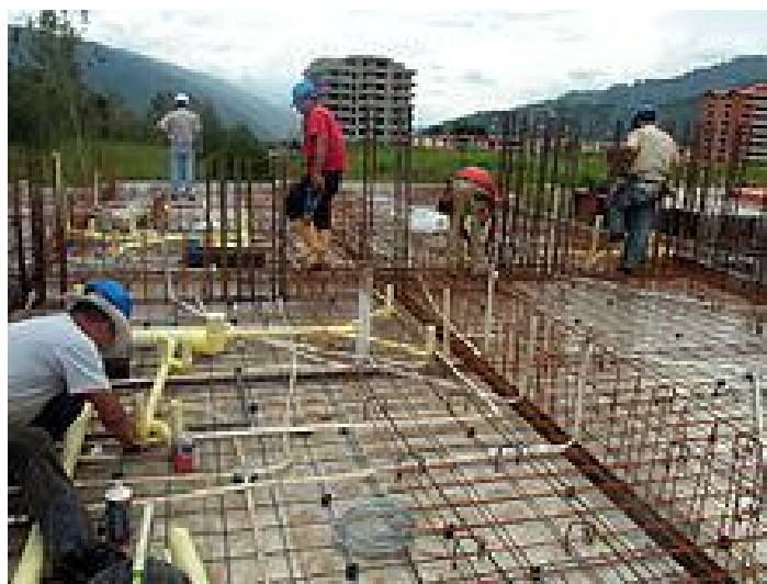
Рисунок 1.2 – Вкладання арматури перед заливанням бетону при спорудженні залізобетонної монолітної конструкції
