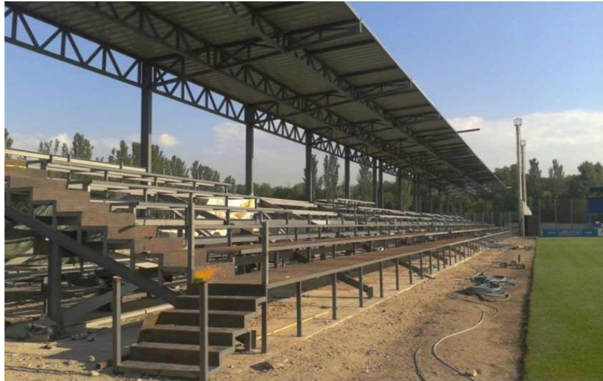
Рисунок 3.13 - Конструкція стаціонарного покриття над трибунами стадіону СК «Олімпік»
