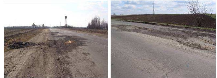
Рисунок 1.2 – Руйнування покриття, спричинені несприятливим водно-тепловим режимом
