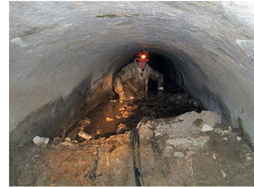
Рисунок 4.2 – Ремонт елементів системи водовідведення
