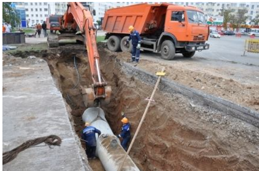
Рисунок 4.3 – Ремонт систем водовідведення
