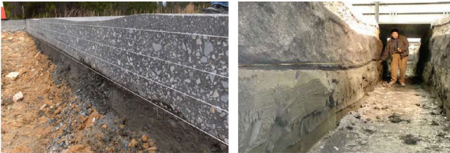
Рисунок 1.4 – Натурне дослідження пошарового утворення залишкових деформацій в шарах конструкції нежорсткого одягу
