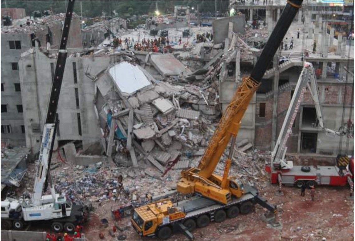
Рисунок 1.20 – Наслідки обвалення будівлі
