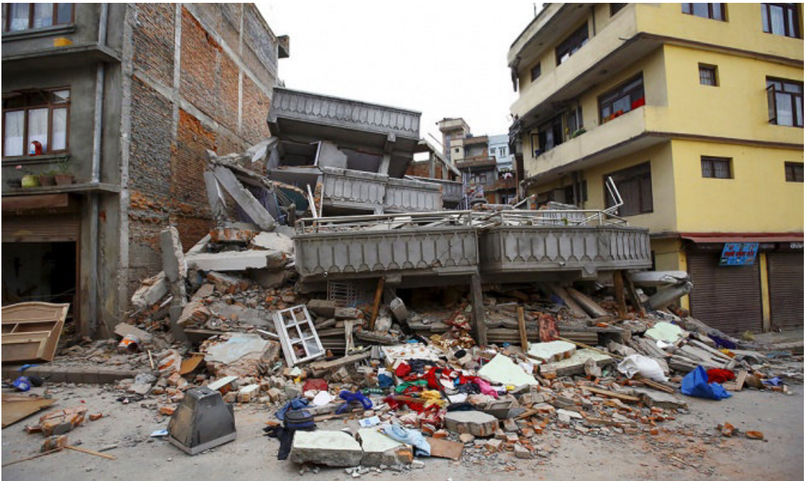
Рисунок 1.8 – Обрушення будинків в Індії в ущільненій забудові
