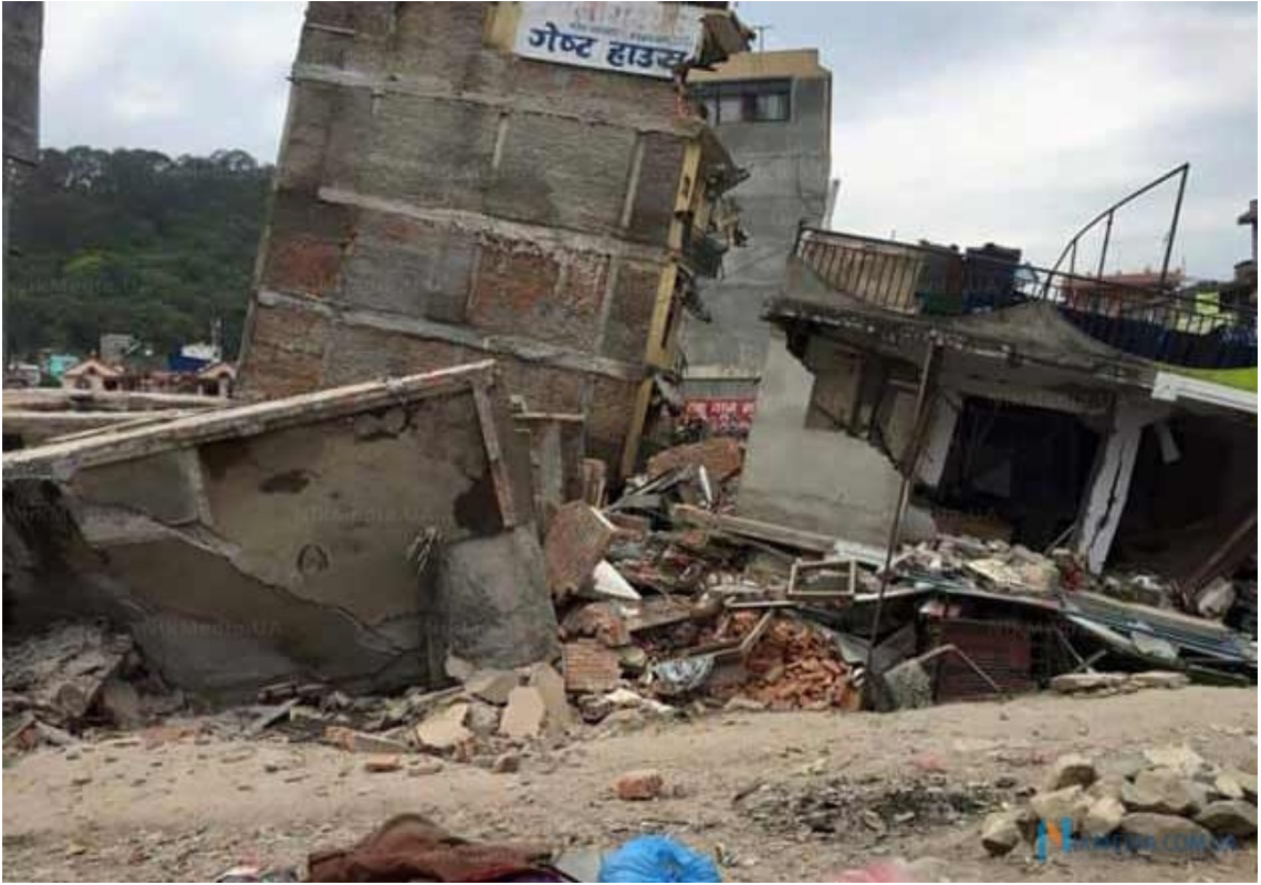
Рисунок 1.6 – Обрушення будинків в Індії в ущільненій забудові
