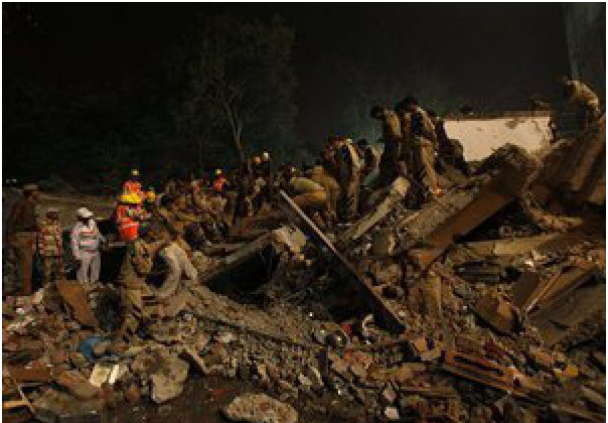
Рисунок 1.1 – Наслідки обрушення будинку в Індії
