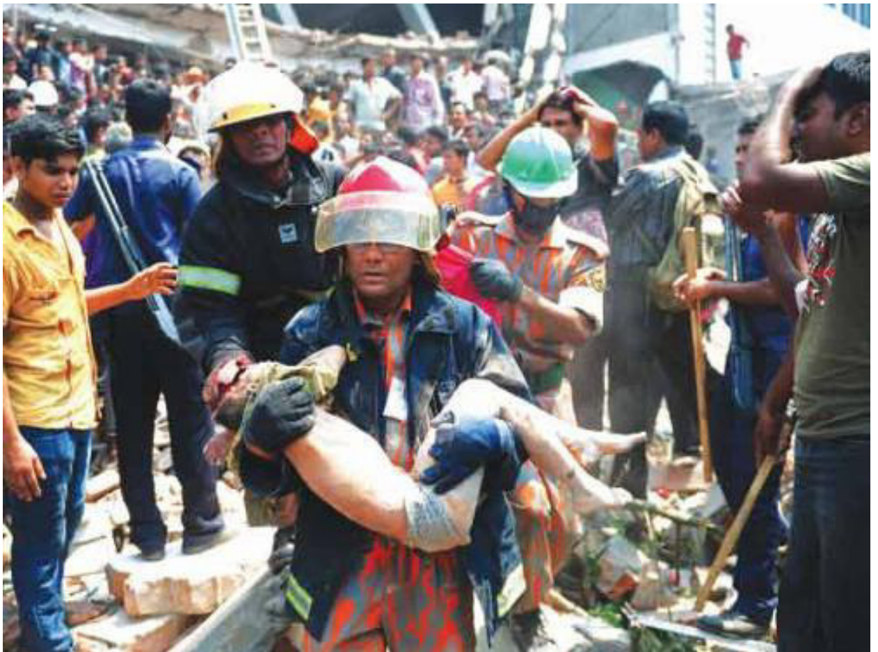
Рисунок 1.21 – Рятувальні роботи після обрушення будівлі
