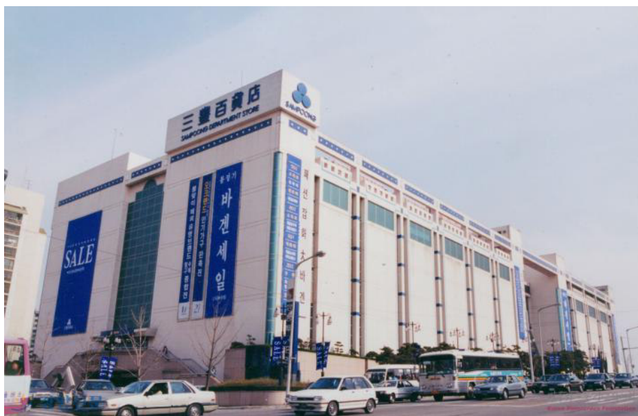
Рисунок 1.9 - Вигляд супермаркету Samroong до руйнування
