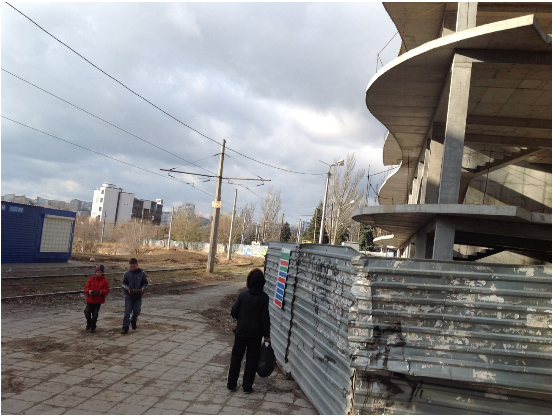
Рисунок 2.8 – Прилегла територія: новобуд, трамвайні колії, котлован
