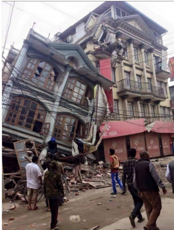
Рисунок 1.3 – Обрушення будинку в Індії в ущільненій забудові
