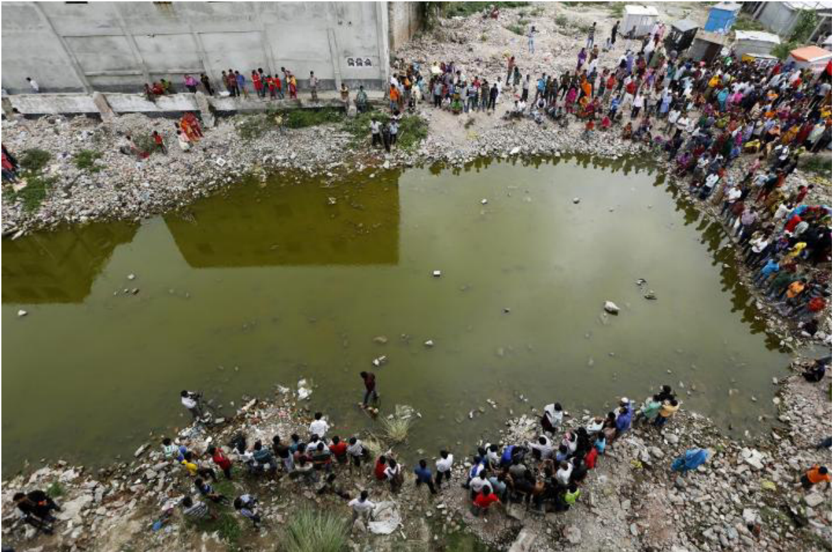
Рисунок 1.22 – Одна із причин обвалення будівлі
