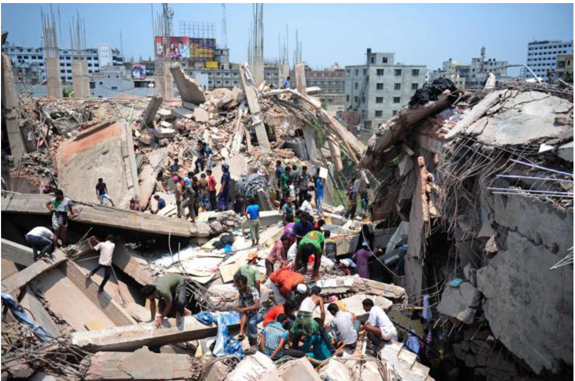
Рисунок 1.19 – Наслідки обрушення будівлі
