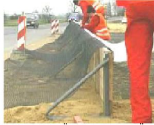
г) укладання торцевої геотекстильної прокладки
