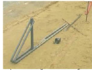
а) металевий упор опалубки
