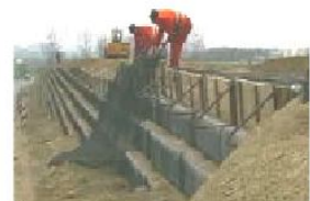
є) укладання нового шару
