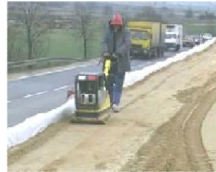
е) ущільнення торцевої частини ручною віброплитою
