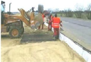
д) засипання армуючого полотна ґрунтом
