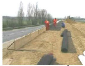
б) встановлення тимчасової опалубки
