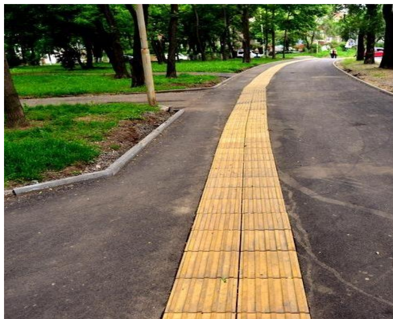
Рисунок 3.23 – Приклад виконання прогулянкових доріжок з тактильною плиткою
