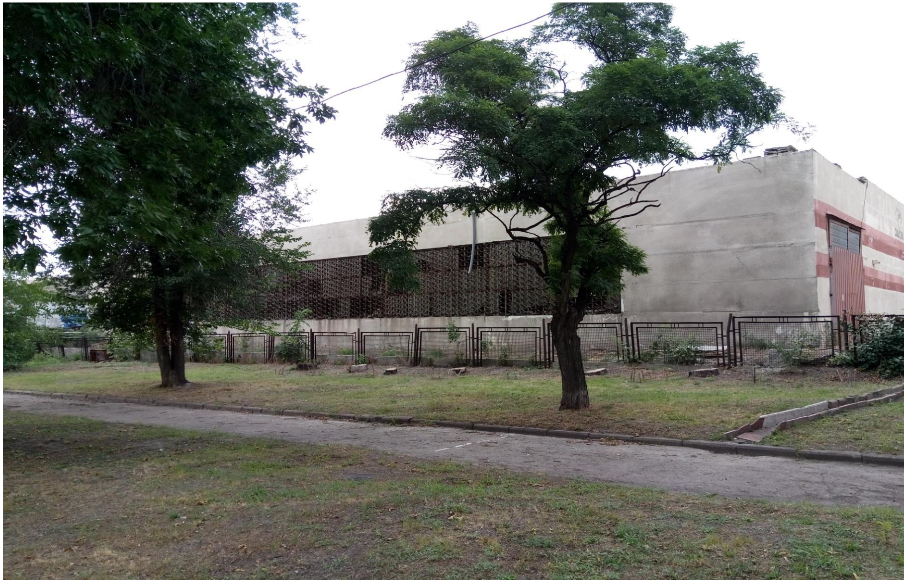
Рисунок 2.3 – Загальний вид будівлі майстерні-складу (фасад 1-9).
