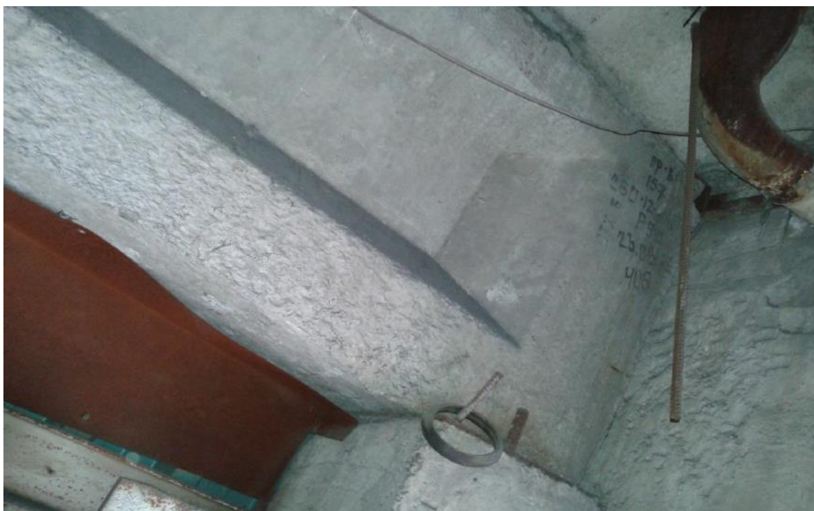
Рисунок 2.7 – Маркування збірної балки покриття.
