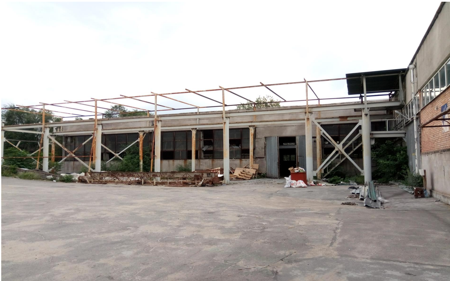
Рисунок 2.1 – Загальний вид будівлі майстерні-складу (фасад 9-3).
