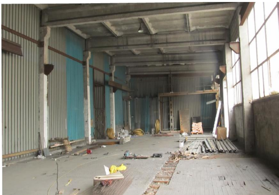
Рисунок 2.5 – Технічний стан зовнішніх і внутрішніх стін будівлі.
