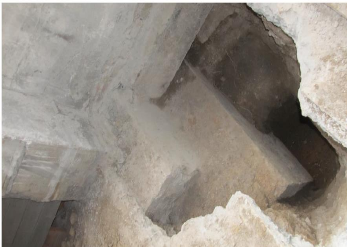
Рисунок 2.4 – Шурф фундаменту по вісі 2.
