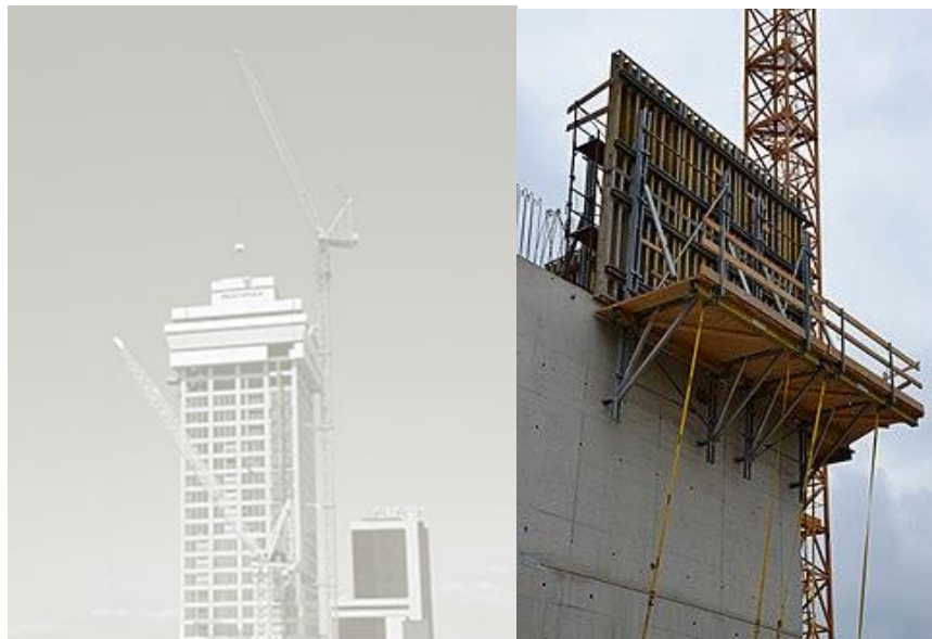
Рисунок 1.26 – Висотна будівля. Нова Зеландія. Такапуна. Робоча платформа опалубки, що ковзає
