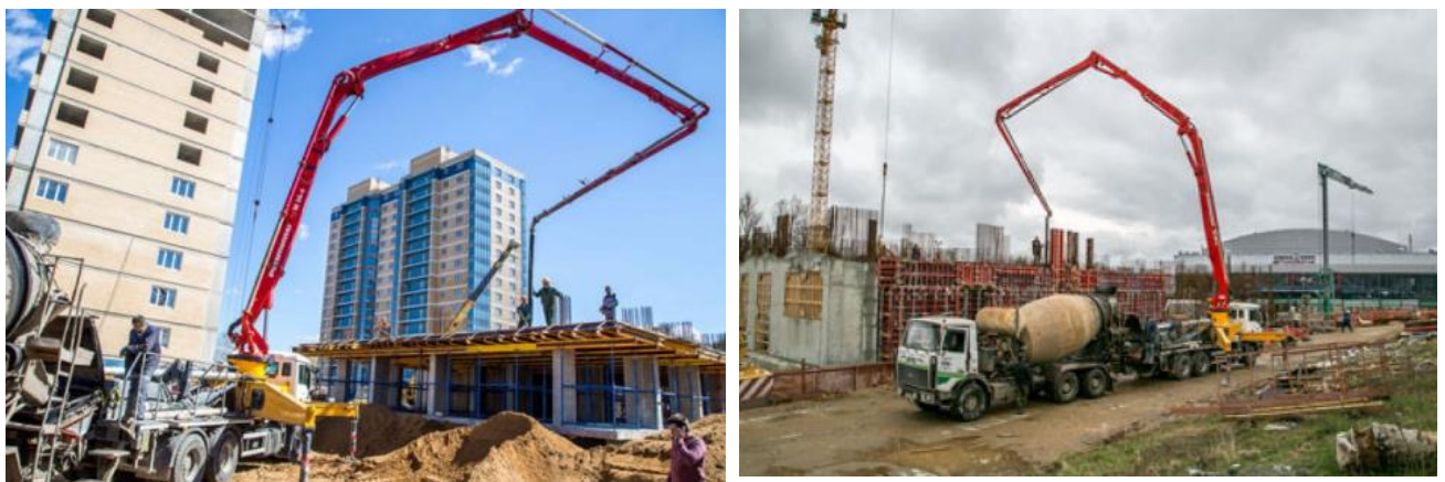
Рисунок 1.3 – Робота автобетононасосу М 36-4,М 36-4 (BSF 36.16 Н)
