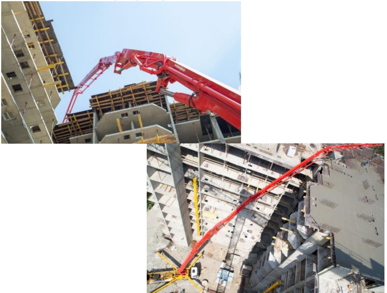
Рисунок 1.4 – Робота автобетононасосу М 56-5, М 56-5.16 Н
