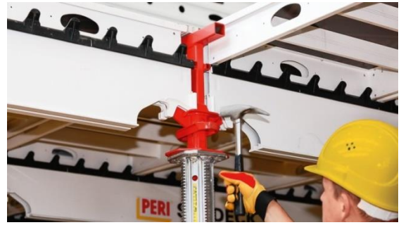
Рисунок 1.37 – Звільнення верхньої відкидної частини одним ударом молотка
