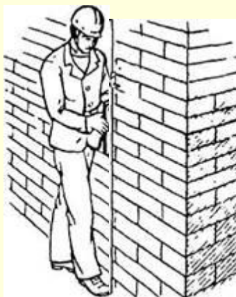
Рисунок 2.25 Підготовка вертикальних поверхню під облицювання
