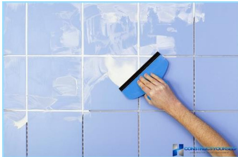
Рисунок 2.14 – Розфарбовування швів між плиткою
