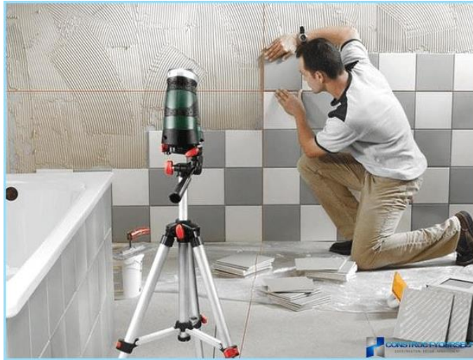
Рисунок 2.11 – Контроль за точністю облицювань
