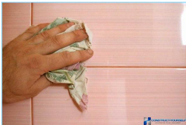
Рисунок 2.15 – Прибирання з поверхні плитки ганчиркою
