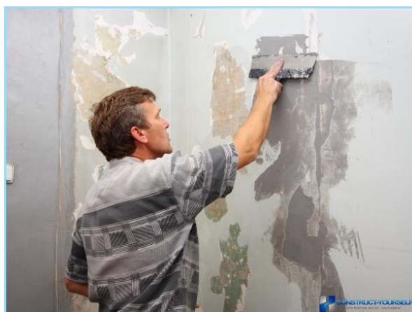
Рисунок 2.1 – Роботи з підготовки поверхні
