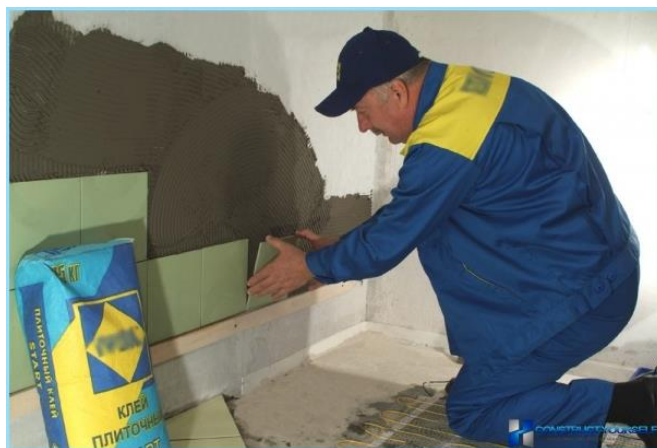
Рисунок 2.12 – Процес приклеування плитки
