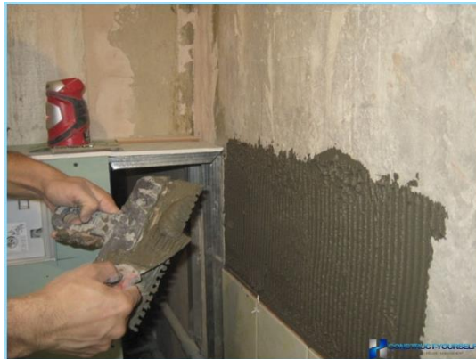
Рисунок 2.9 – Підготовка поверхні
