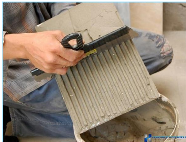
Рисунок 2.10 – Нанесення розчину на плитку
