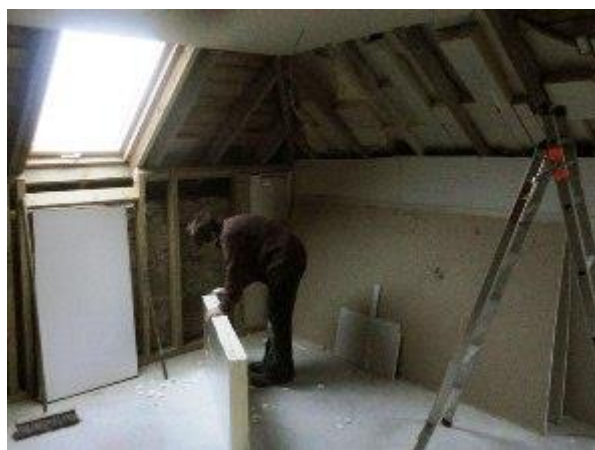
Рисунок 2.4 - Приклад внутрішньої теплоізоляції плитами ДВП.
