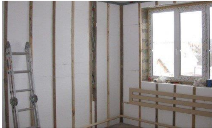
Рисунок 2.3 - Приклад внутрішньої теплоізоляції пінопластом
