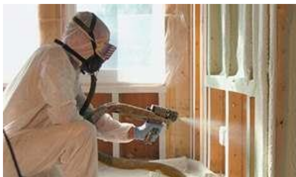
Рисунок 2.5 - Приклад внутрішньої теплоізоляції з пінополіуретану.
