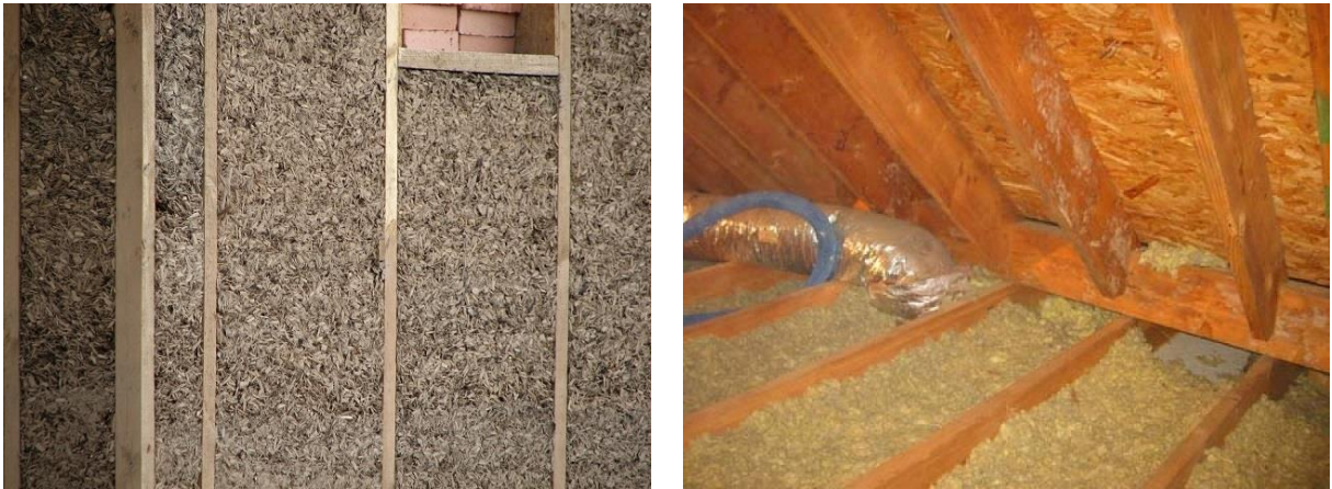
Рисунок 2.6 - Приклад внутрішньої теплоізоляції з тирси.
