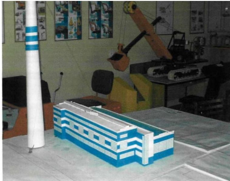
Рисунок 2.4 - Макет монтажної системи Квадро-1 для умов Одеської ТЕЦ-3 в масштабі 1: 200
