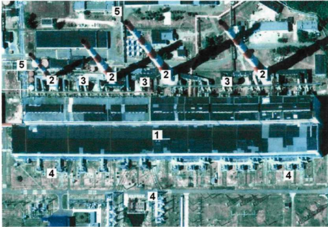
Рисунок 1.4 - Загальний вигляд Київської ТЕС:
