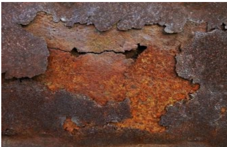
Рисунок 7 – Корозія металевої колони
