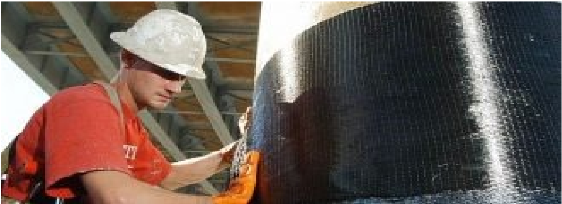
Рисунок 29 – Монтаж углеволокна
