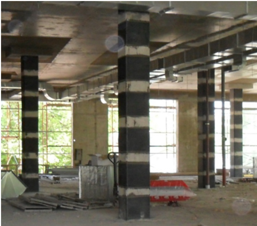
Рисунок 21 – Приклади посилення залізобетонних колон вуглеволоконном
