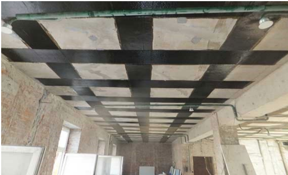
Рисунок 19 – Приклади посилення залізобетонних балок вуглеволокном
