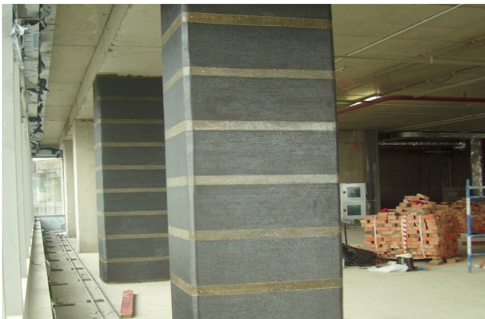
Рисунок 10 – Приклади посилення залізобетонних колон вуглеволокном
