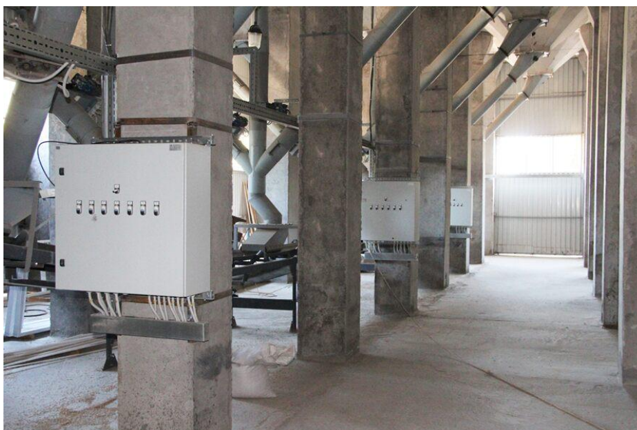
Рисунок 3.3. – Шафи управління
