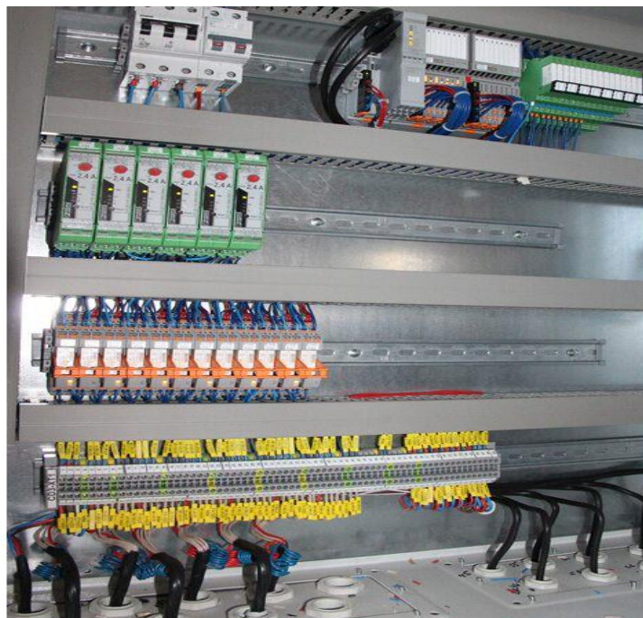
Рисунок 3.4 - Шафа управління з пристроями вводу-виводу «Axioline» і гібридними реверсивними пускачами « Conatron »
