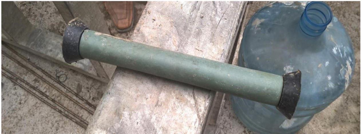
Рисунок 2.13 – Конструкція ПВХ втулок для утримання анкерних стяжок
