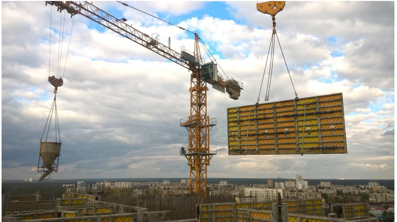
Рисунок 2.12 – Подача щитів опалубки на монтажний горизонт будівлі
