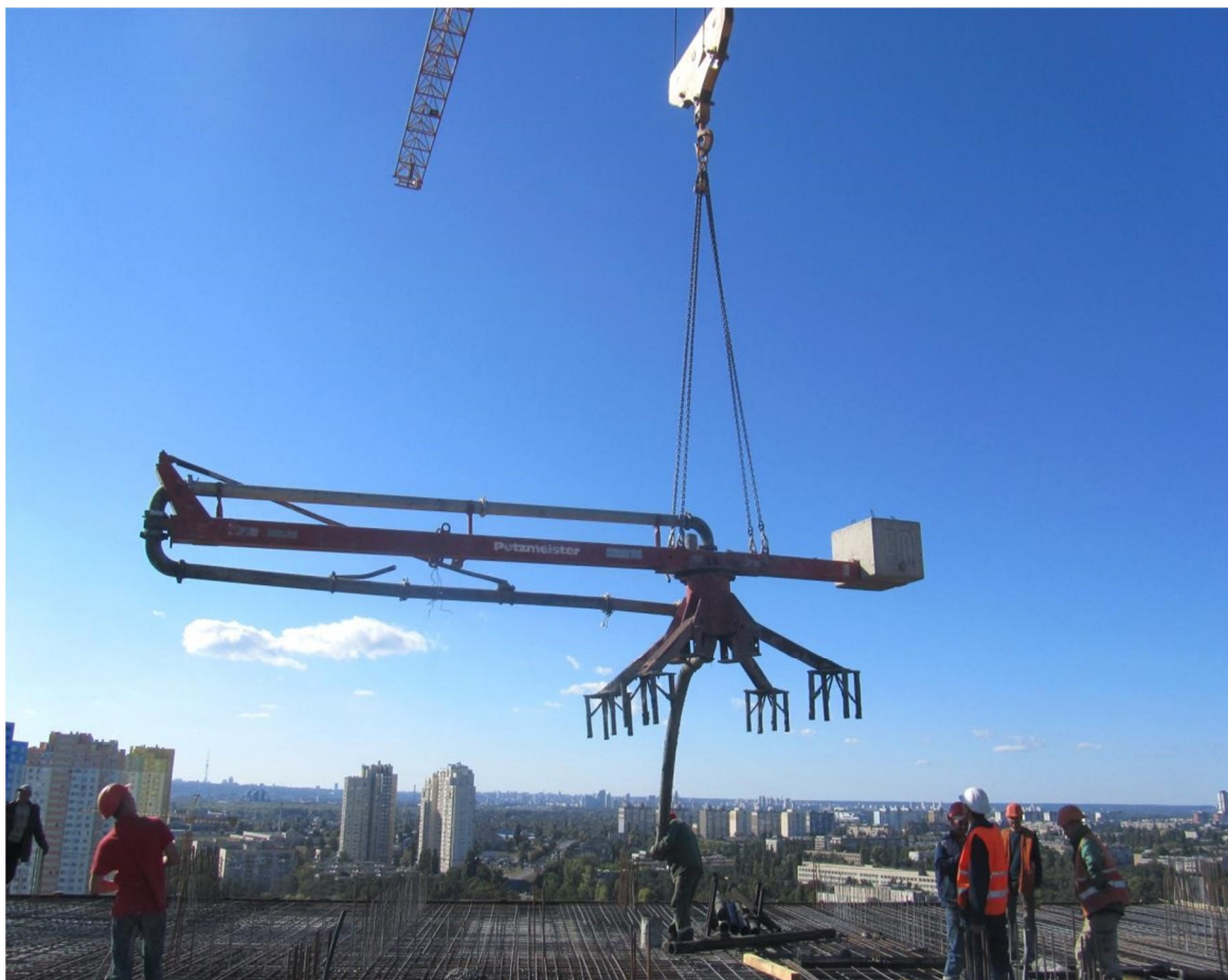
Рисунок 2.6 – Монтаж механічної розподільної стріли “Putzmeister” на технологічній захватці монтажного горизонту
