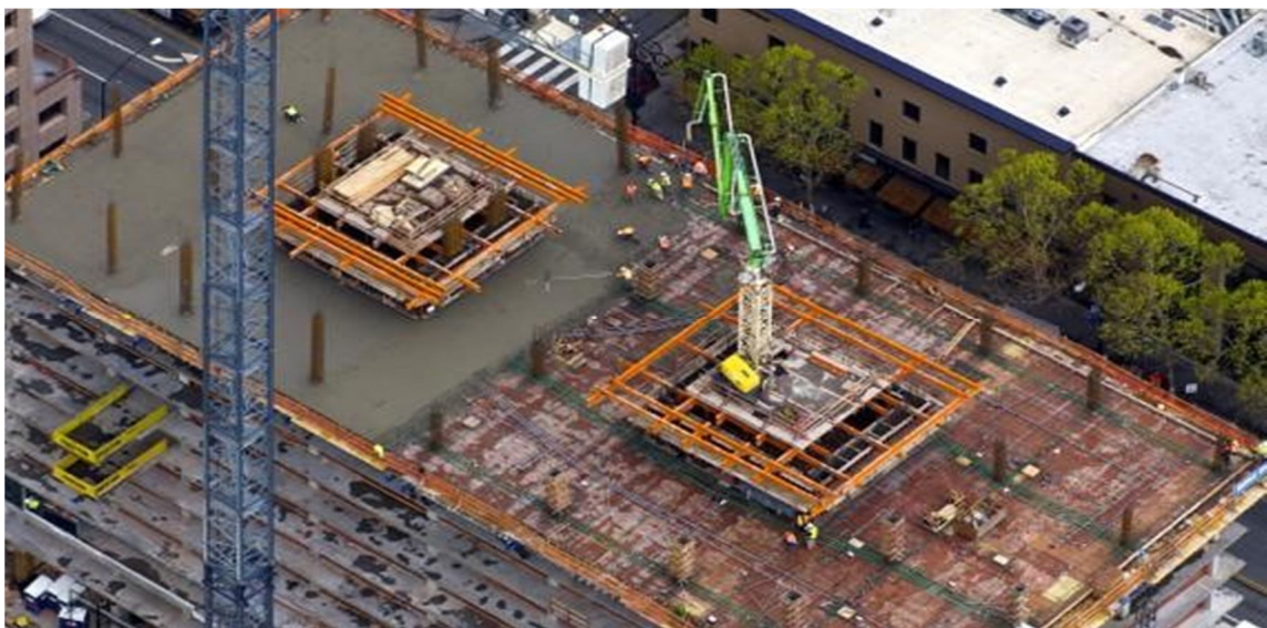
Рисунок 1.4 – Бетонування конструкцій самопідйомною гідравлічною розподільною стрілою Putzmeister (м. Лос-Анджелес, США)
