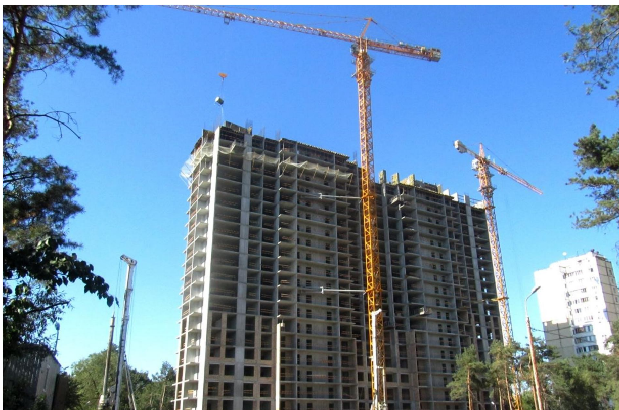
Рисунок 2.3 – Зведення каркасу будівлі за допомогою баштових кранів FO 23B та Potain MC 175B
