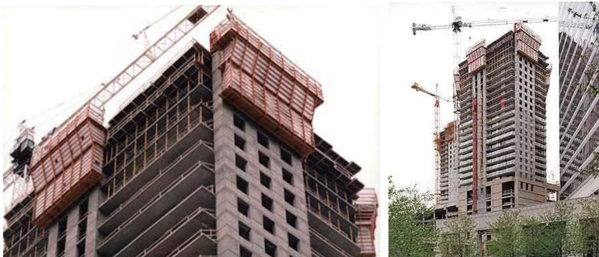
Рисунок 1.7 – Зведення будівлі “The Grand Plaza” за допомогою систем ковзної опалубки Peri ACG (м. Чикаго, США)
