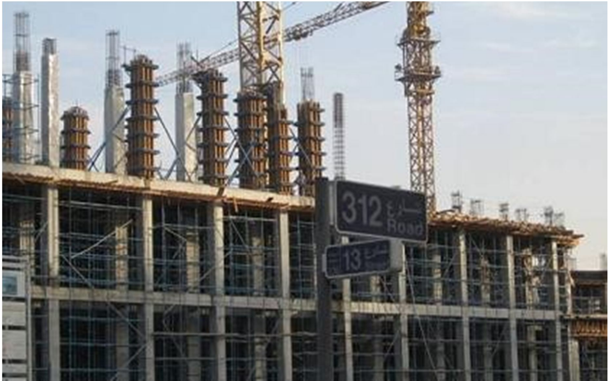
Рисунок 1.5 – Зведення каркасу будівлі з використанням традиційних опалубних систем (м. Дубай, ОАЕ)
