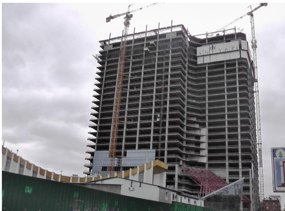
Рисунок 1.19 – Зведення каркасу громадського комплексу “Sky Towers” в м. Київ
