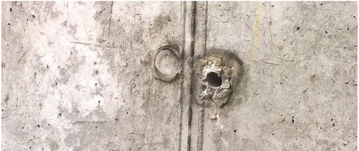
Рисунок 2.15 – Отвори для втулок, утворені в тілі бетонної конструкції
