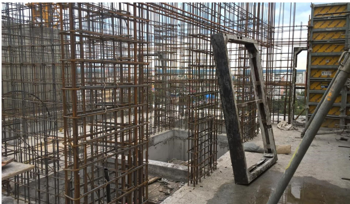
Рисунок 2.10 – З'єднання арматурних стрижнів вертикальних елементів за технологією ручної в'язки
