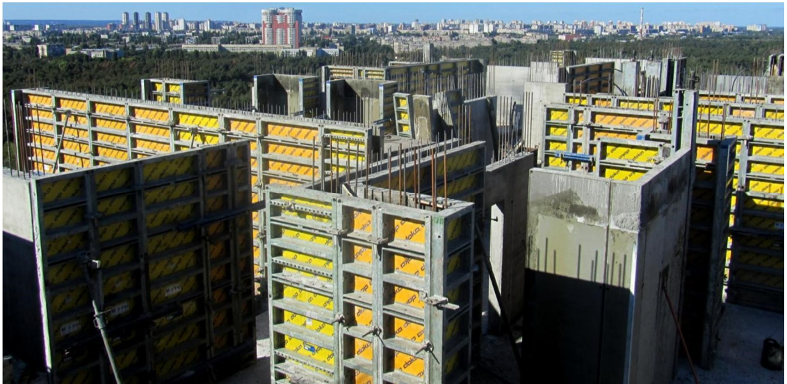
Рисунок 2.17 – Зведення каркасу будівлі з використанням комбінованої щитової опалубки “Doka”
