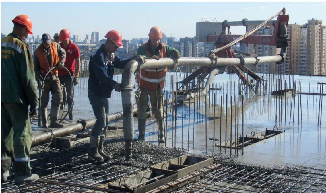
Рисунок 2.7 – Бетонування плити перекриття за допомогою механічної розподільної стріли “Putzmeister”
