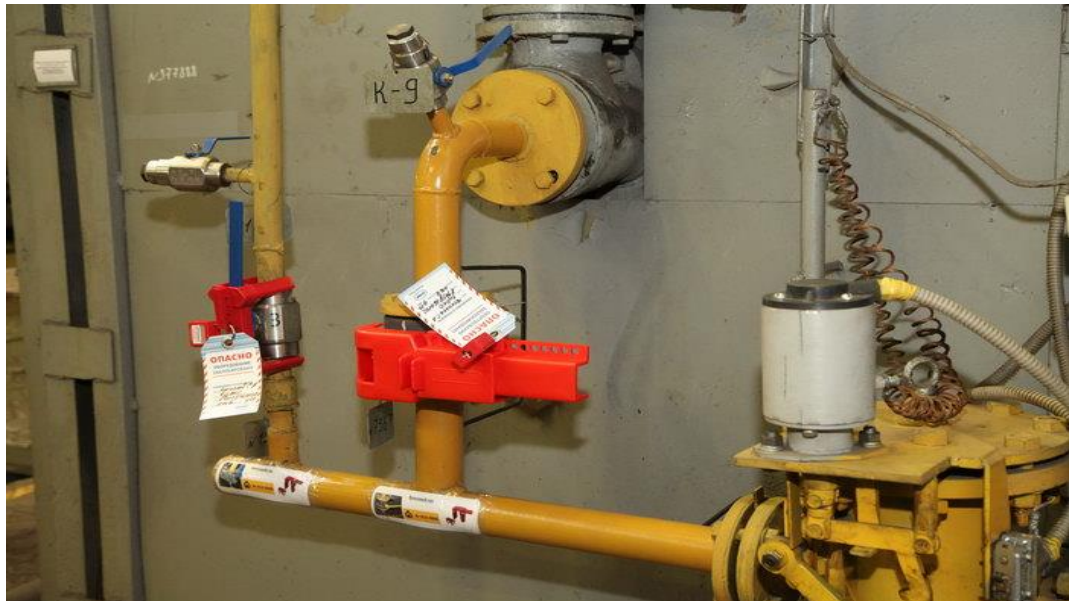
Рисунок 3.4—Приклад застосування системи LOTO
