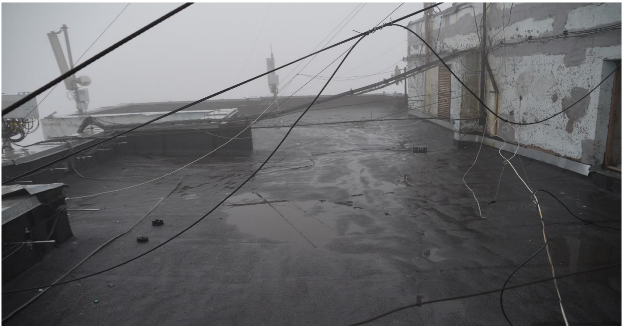
Рисунок 2.2 – Фотографія покрівлі будівлі
