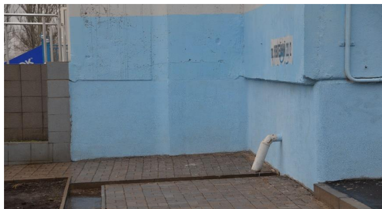
Рисунок 2.3 – Фотографія цокольної частини будівлі
