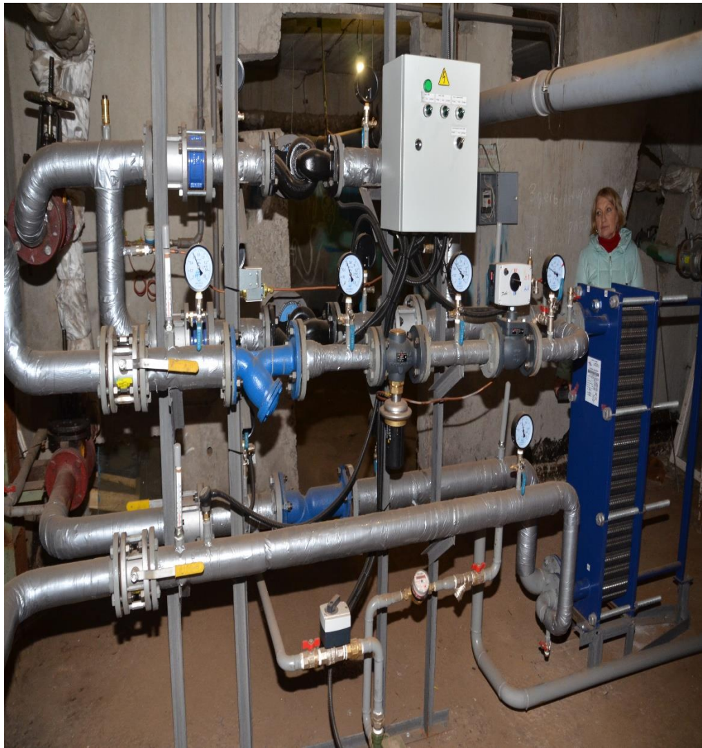
Рисунок 2.4 – Фотографія цокольної частини будівлі
