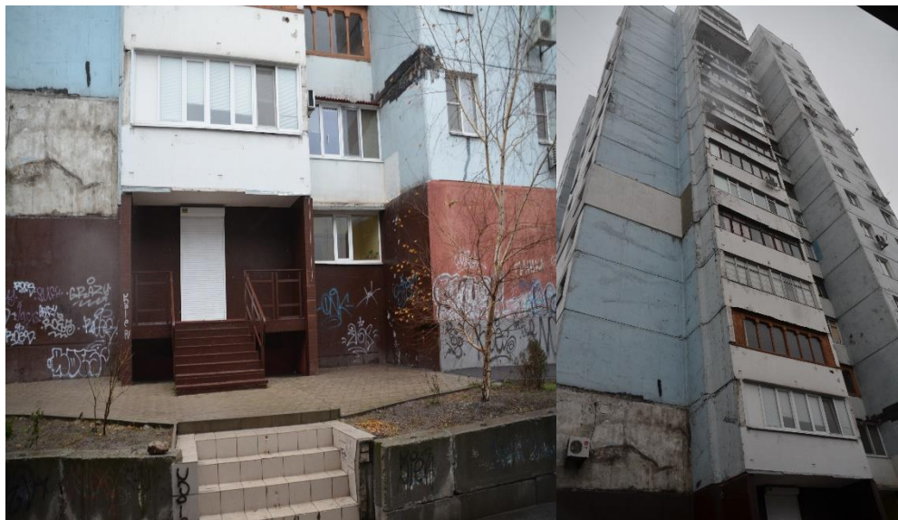
Рисунок 2.1 – Фотографія стін будівлі
