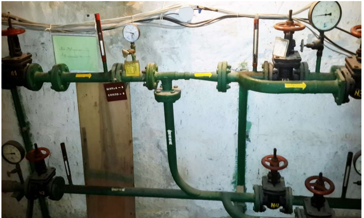
Рисунок 1.3 – Теплопункт елеваторного типу
