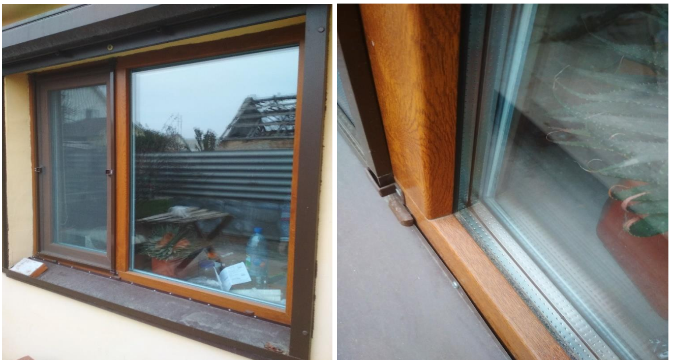
Рисунок 1.10 – встановлене вікно з подвійними склопакетами в пластиковій рамі.
