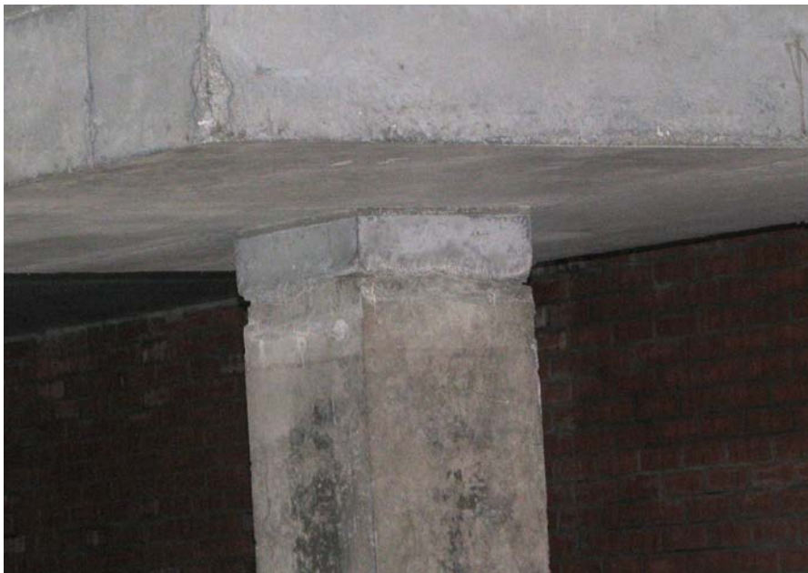
Рисунок 2.25 - робочий шов колони
