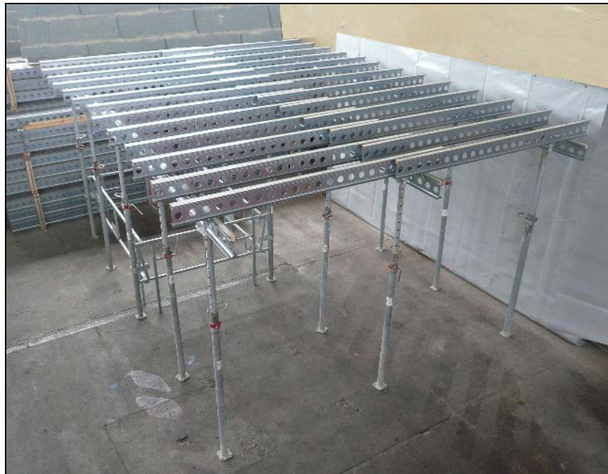
Рисунок 3.16 – Металічна балка у системі горизонтальних риштувань.
