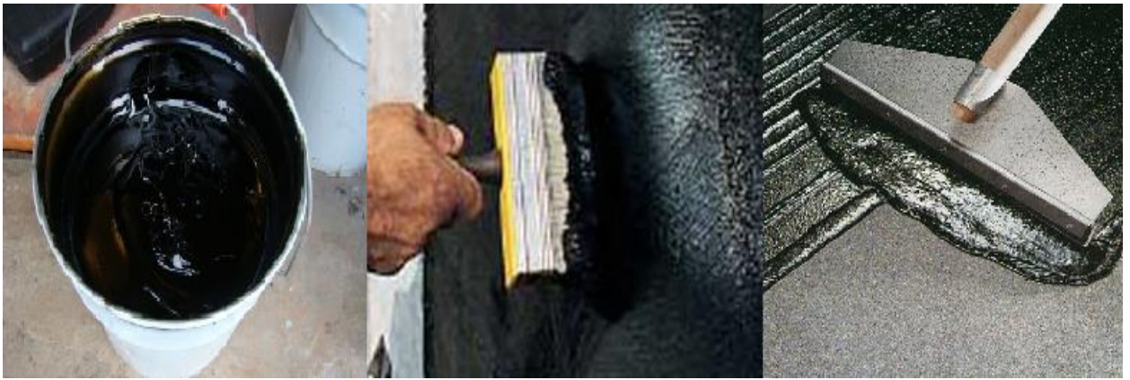
Рисунок 2.6 – Обмазувальна гідроізоляція
