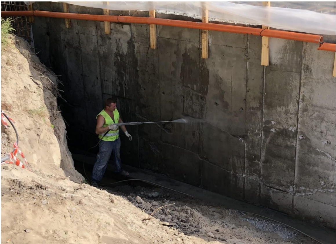
Рисунок 2.5 – Змивання пилу та бруду з поверхні фундамент
