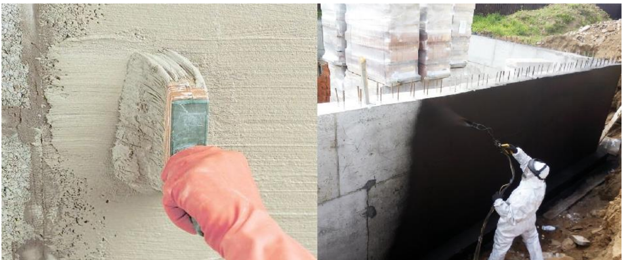
Рисунок 2.8 – Фарбувальна гідроізоляція
