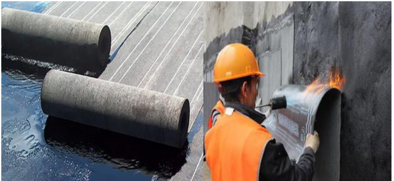
Рисунок 2.7 – Обклеювальна гідроізоляція
