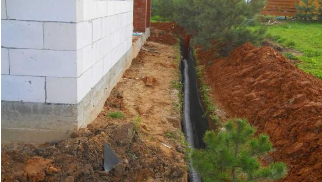
Рисунок 3.7 – Кільцевий дренаж
