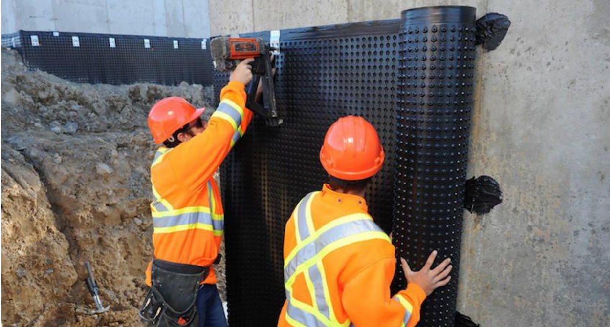
Рисунок 1.3 – Кріплення профільованої мембрани
