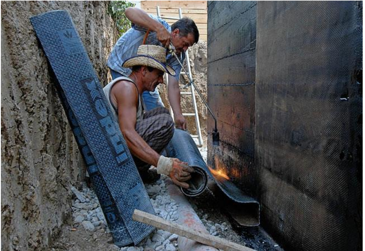
Рисунок 1.2 – Приклеювання рулонної гідроізоляції
