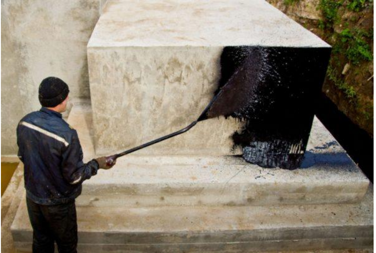
Рисунок 1.1 – Нанесення бітумної мастики
