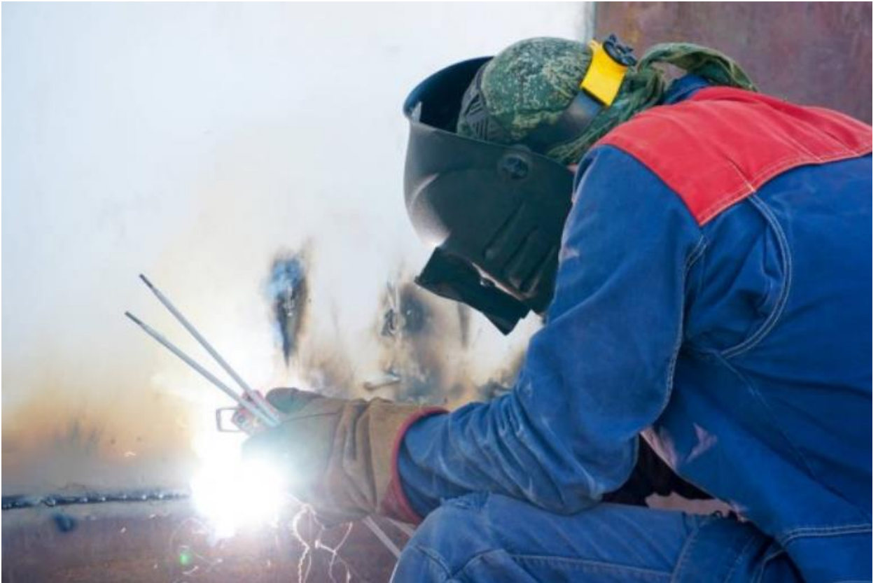
Рисунок 2.13 – Монтаж металевої гідроізоляції
