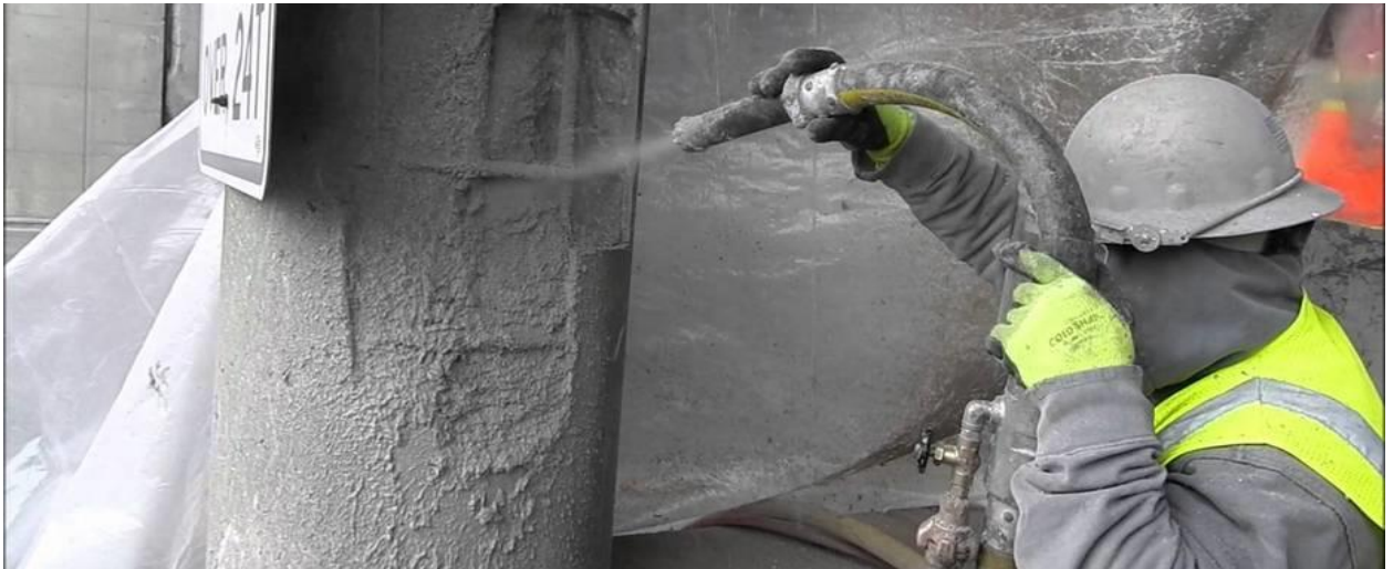
Рисунок 2.12 – нанесення розчину методом торкретування
