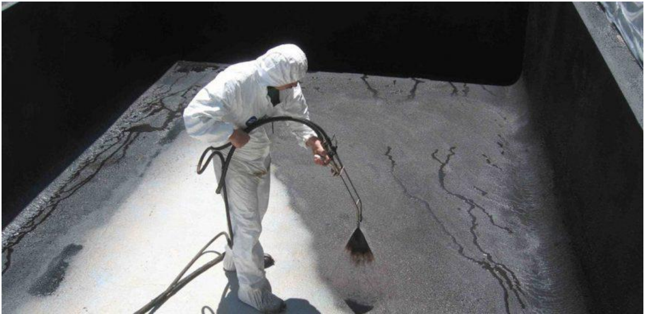
Рисунок 3.3 – Нанесення рідкої гуми
