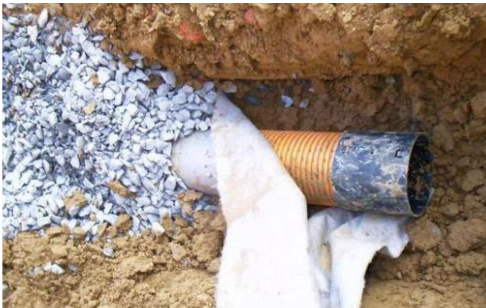
Рисунок 3.9 – Захист дренажних труб геотекстилем та обсипкою
