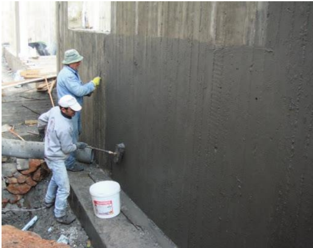
Рисунок 1.4 – Нанесення просочувальної гідроізоляції
