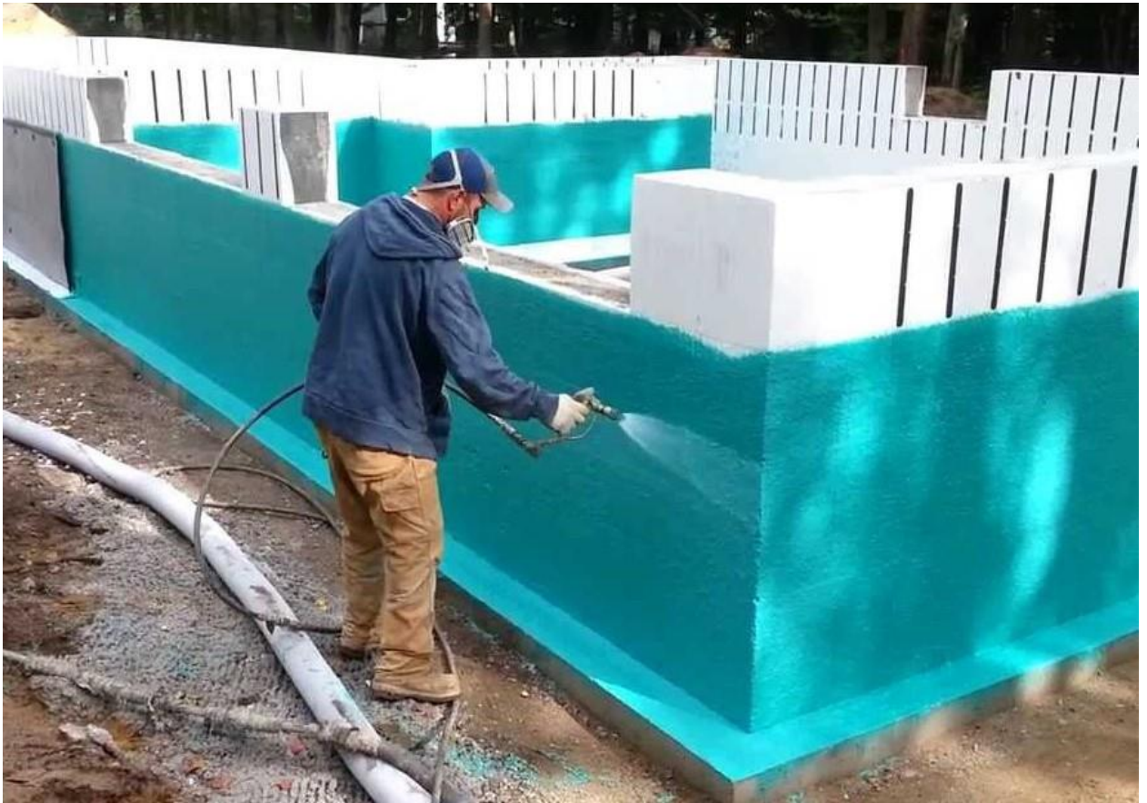
Рисунок 3.4 – Розпилення полісечовини
