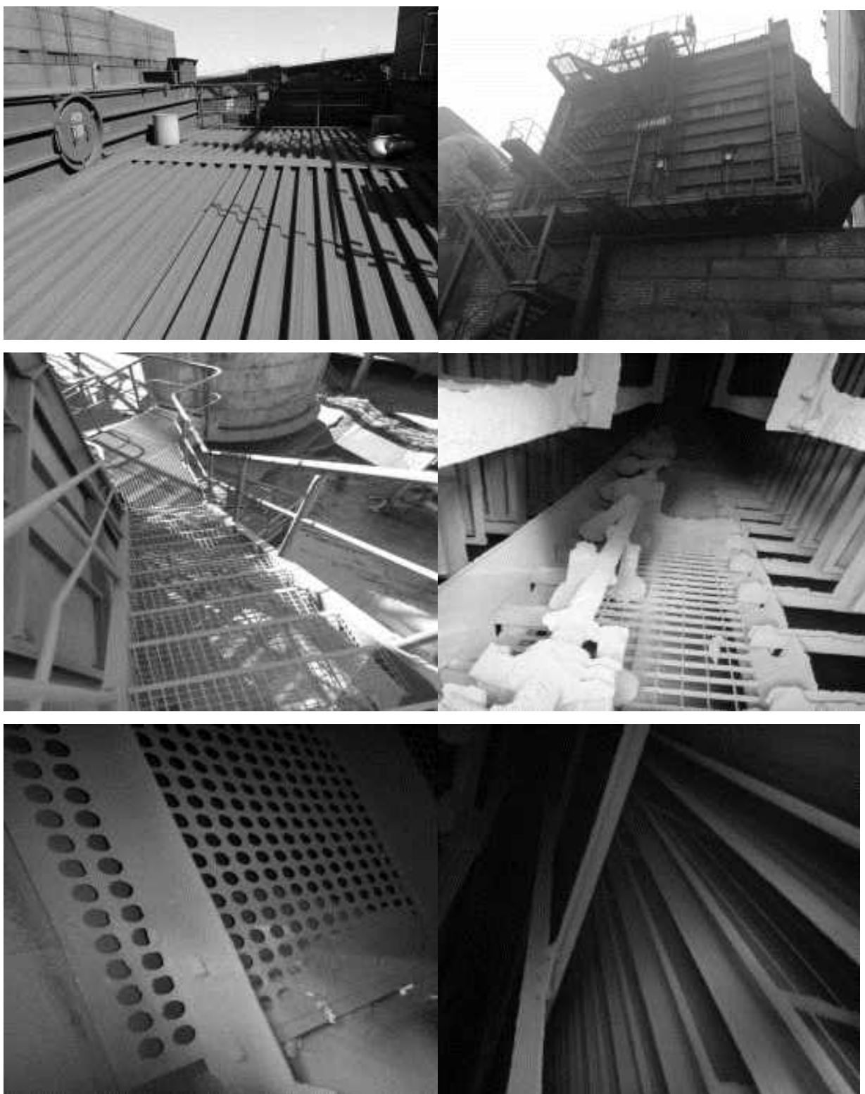
Рисунок 3.8 - Технічний стан електрофільтрів зони сушки і підігріву № 101
