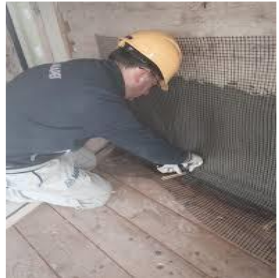
Рисунок 2.4 - Нанесення вуглецевих сіток
