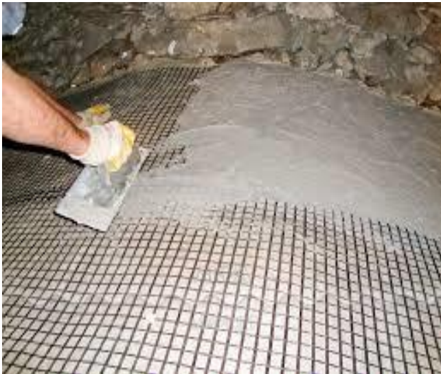
Рисунок 2.4 - Нанесення вуглецевих сіток
