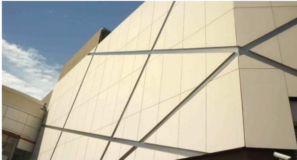
Рисунок 2.7 - Фіброцементні фасадні конструкції
