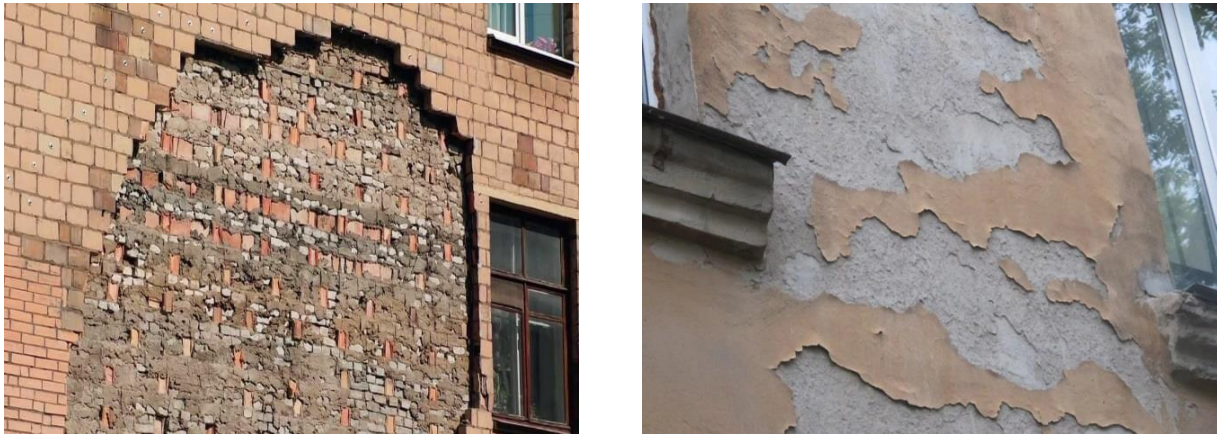
Рисунок 1.1 – Руйнування фасаду від впливу атмосферних осадків.
