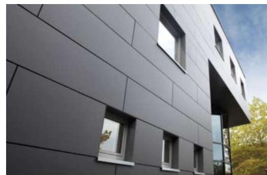
Рисунок 1.8 - Облицювальні матеріали в конструкції вентильованого фасаду
