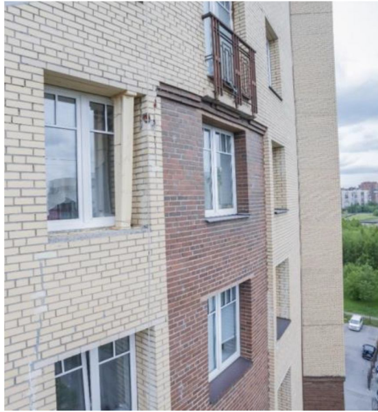
Рисунок 3.15 - Фотографія фасаду з дрона. Для побудови ортофотоплану фасаду виконуються знімки з різних ракурсів
