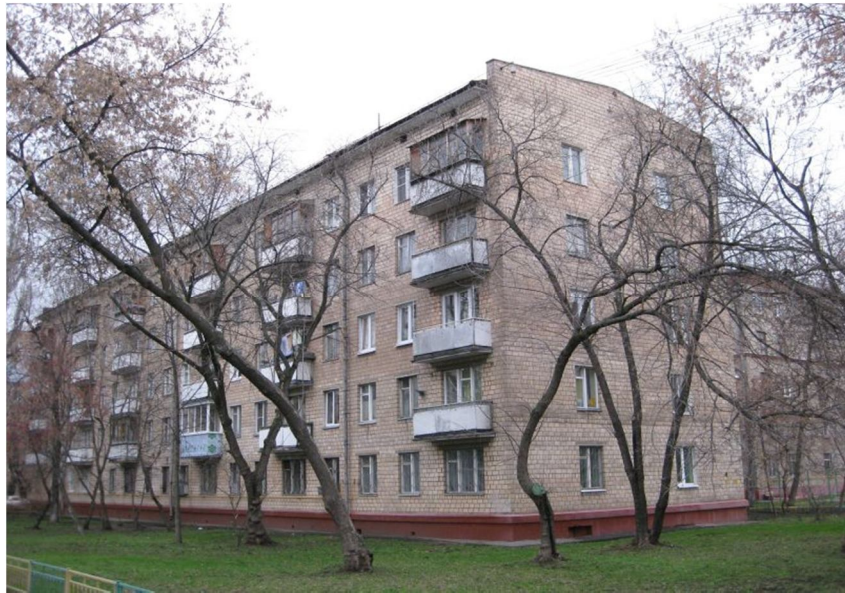
Рисунок 3.25 – Реальне зображення обстежуваної будівлі
