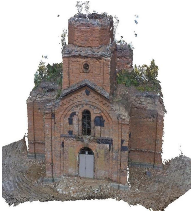
Рисунок 3.9 - Щільна хмара точок формує обриси тривимірної моделі
