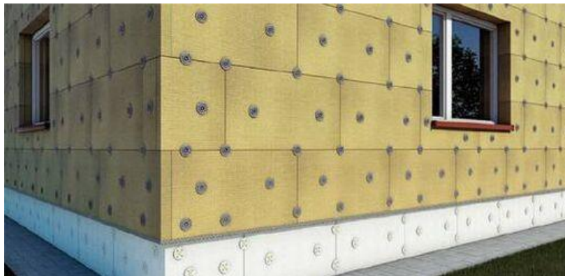
Рисунок 3.1 - Типове конструктивно-технологічне вирішення комбінованого кріплення теплоізоляційного шару контактних систем
