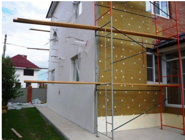
Рисунок 2.1 - Технологія монтажу мокрого фасаду
