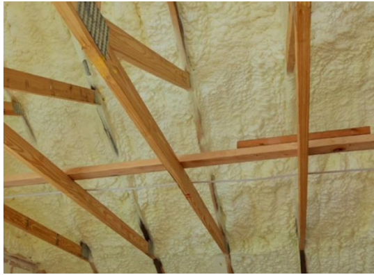
Рисунок 1.14 – Теплоізоляційний матеріал з пінокарбамидно-формальдегідного пінопласту
