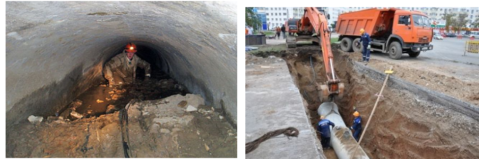
Рисунок 4.2 – Ремонт елементів системи водовідведення
