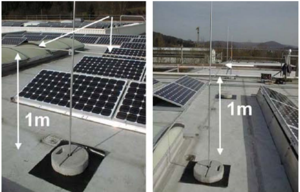
Рисунок 3.4 - Розташування блискавкозахисту сонячних панелей
