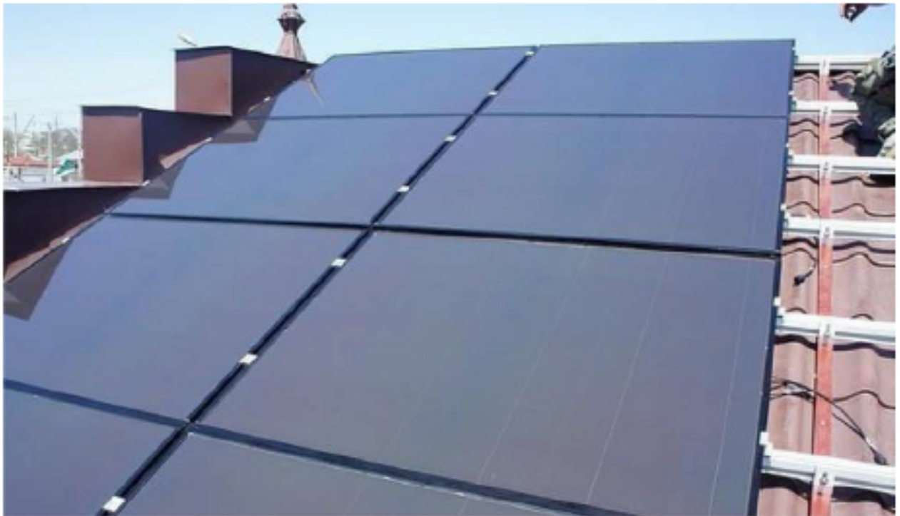
Рисунок 2.14 - Сонячна панель з аморфного кремнію [24]
